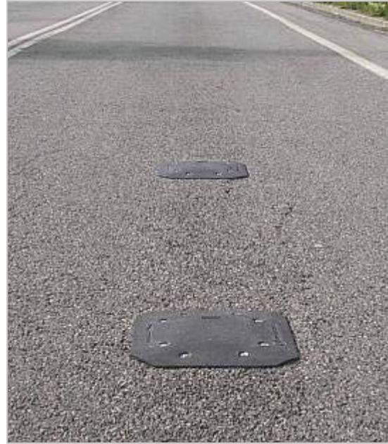
Figura 2.1.5. Installazione raddoppiata per singola corsia
