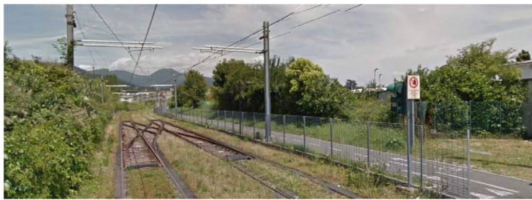
Veduta della situazione esistente
