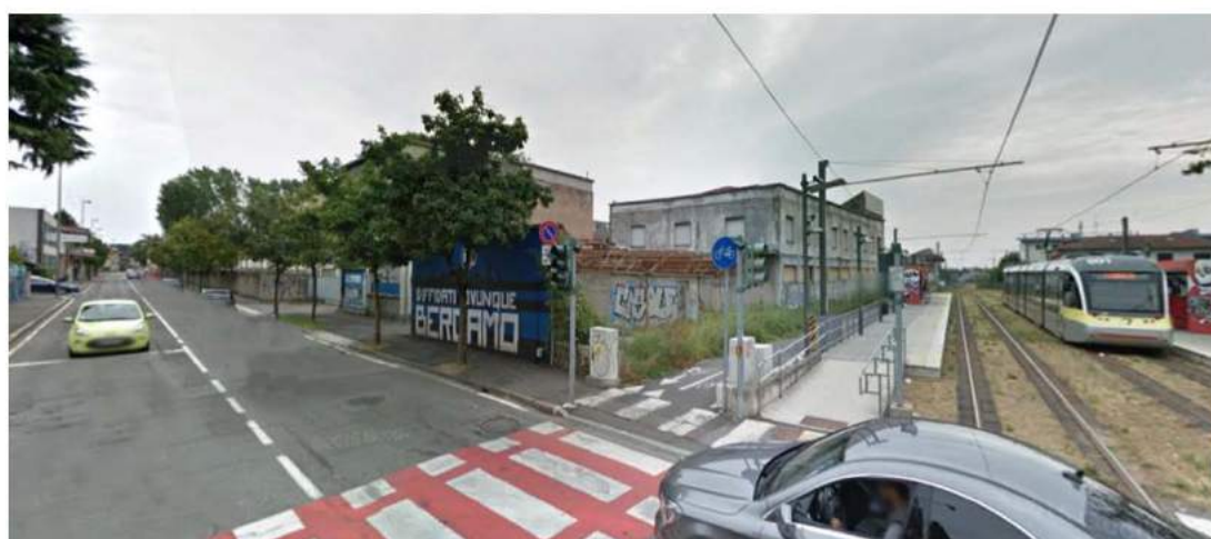
Veduta dalla della situazione esistente
