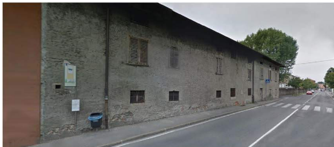
Veduta dalla della situazione esistente
