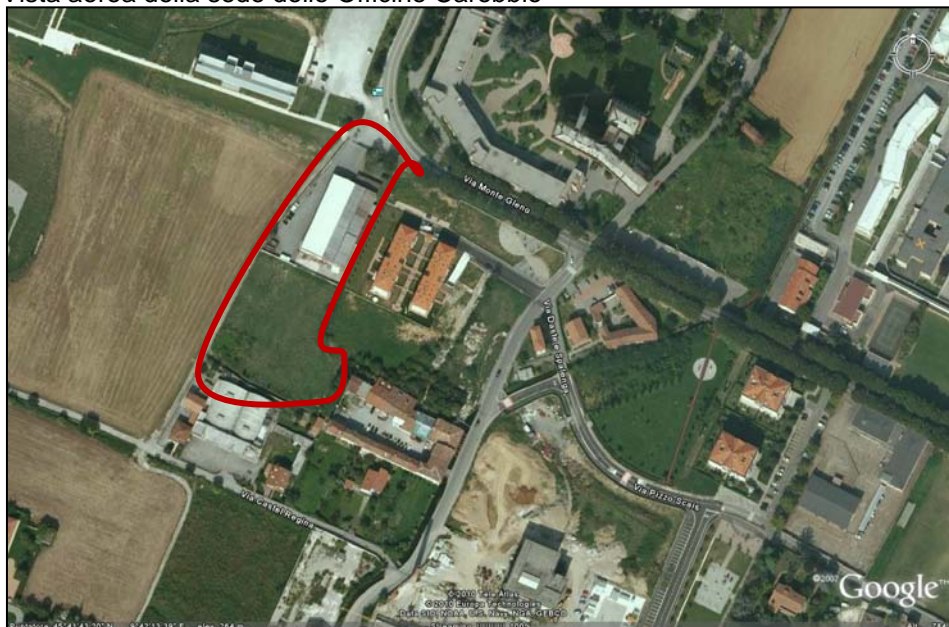
Vista aerea della sede delle Officine Carobbio
