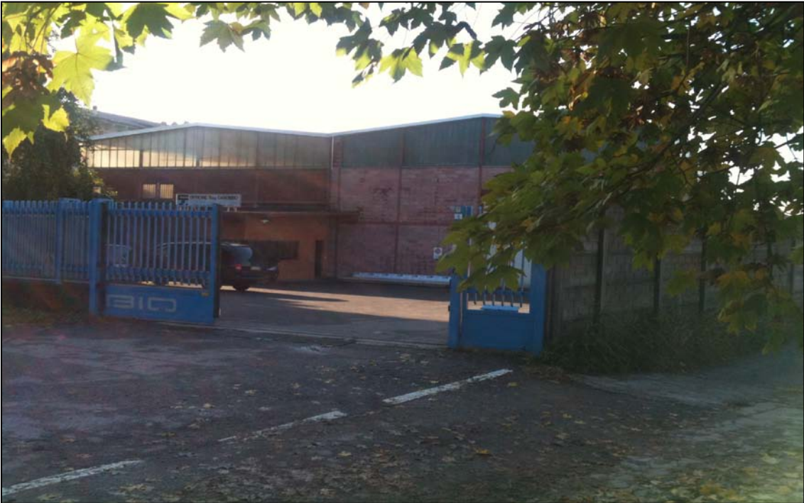
Vista delle Officine Carobbio dall'ingresso di Via Monte Gleno
