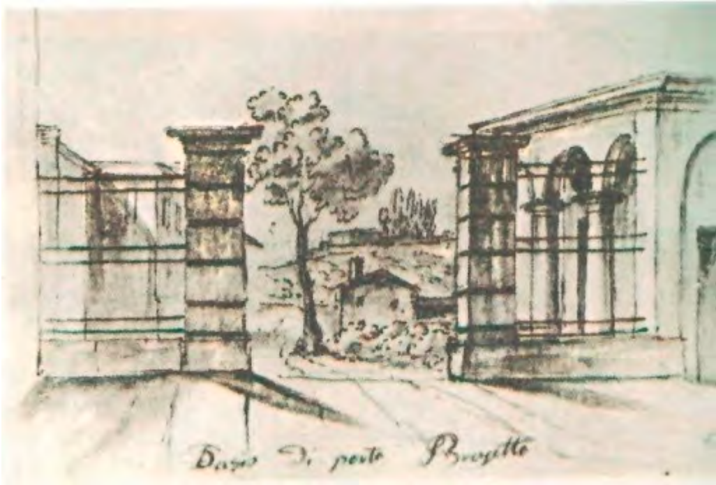
La costruzione del Dazio di Porta Broseta. Sullo sfondo il colle della Benaglia
