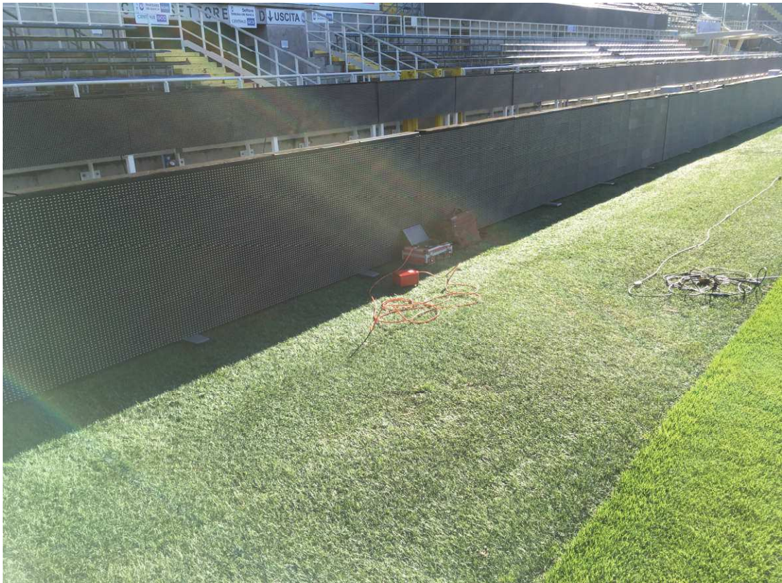
Prova con tromografo n° 2
