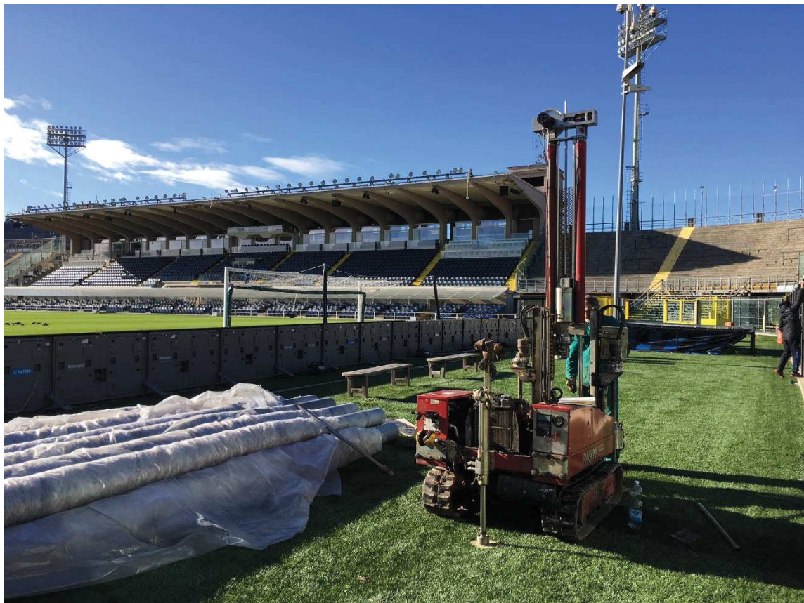
Postazione prova penetrometrica statica n°2
