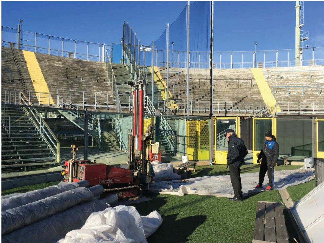
Postazione prova penetrometrica statica n°1
