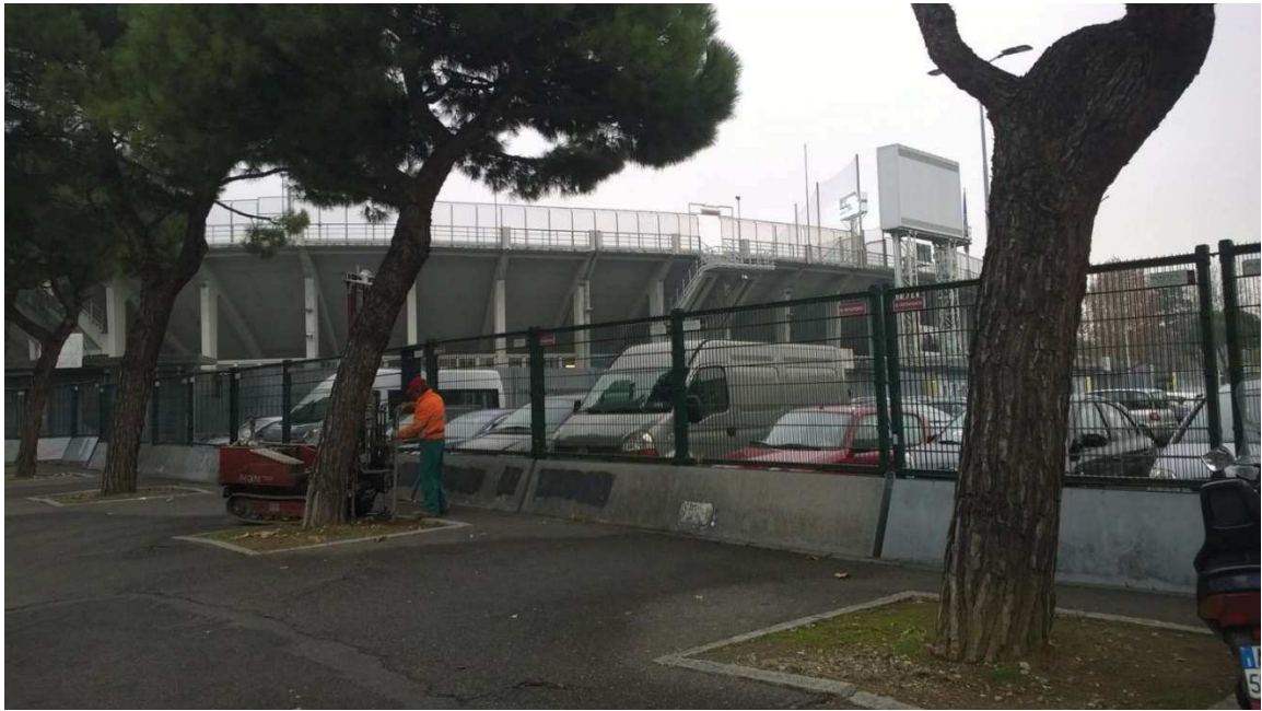
Postazione prova penetrometrica dinamica n°1
