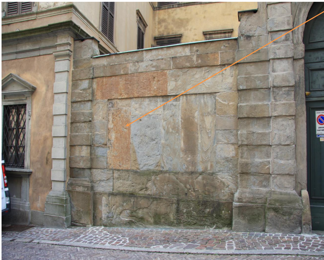
Muratura esterna con rivestimento in lastre di arenaria Via Porta Dipinta (PD_51-52 a)
