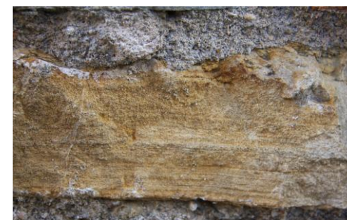
Tamponamenti murari con litologie flischyoidi prevalenti
