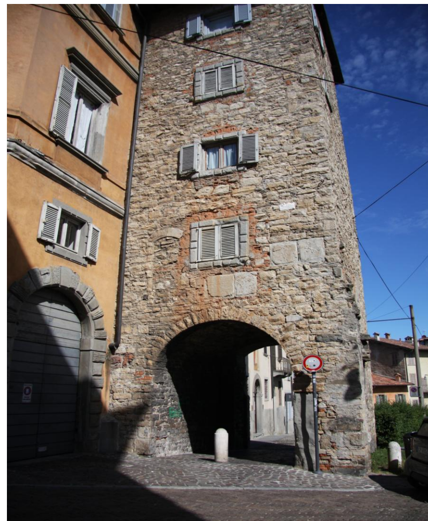
Muratura esterna in Via Porta Dipinta (PD_02): accostamento litotipi calcarei e arenitici – (PD14 a) muratura a vista calcarenitica con inserti in arenaria grigia
