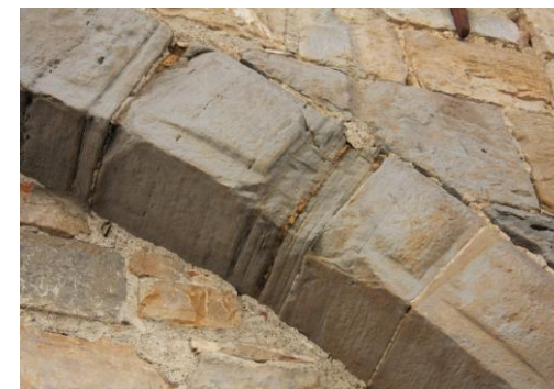
Archi e murature portanti in pietra Arenaria
