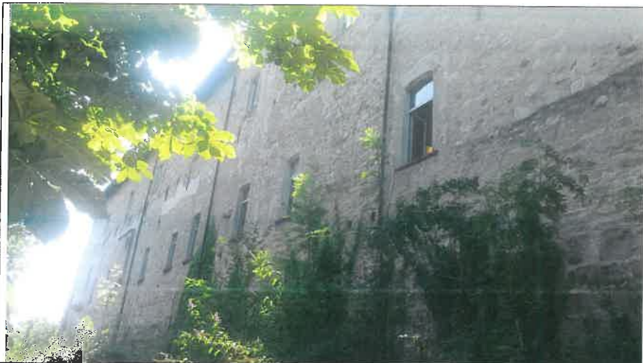
Vista d'insieme, si nota più che altro la presenza di vegetazione infestante, in particolare edera, che si sta diffondendo rapidamente. Anche qui la stilatura risulta con un effetto "raso-sasso" con alcuni lacerti di intonaco.
