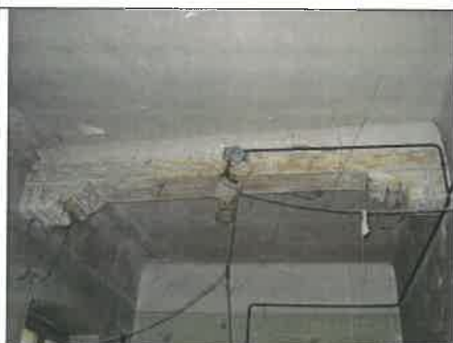
Vista di una grossa trave in legno del corpo di fabbrica "lato piazzale" che verrà trattata nella scheda successiva 11S, ma che è stata richiamata per far vedere il particolare della mensolina che ritroviamo in quasi tutti i travetti del corpo di fabbrica "lato parco". Probabilmente queste sono le travi originarie che non sono mai state sostituite.
