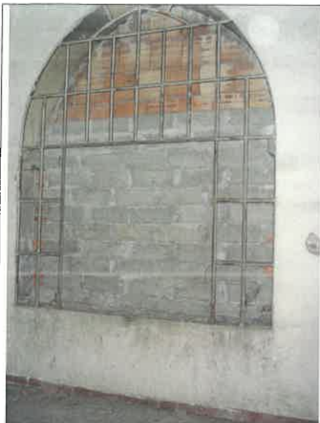
Tamponamento delle finestre ad arco a sesto acuto lato parco, di origine medioevale, con elementi in prisme di cemento e mattoni forati.
