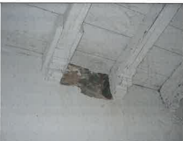
Particolare di un travetto, dove è stata effettuata un'indagine per verificare la consistenza del legno all'appoggio
