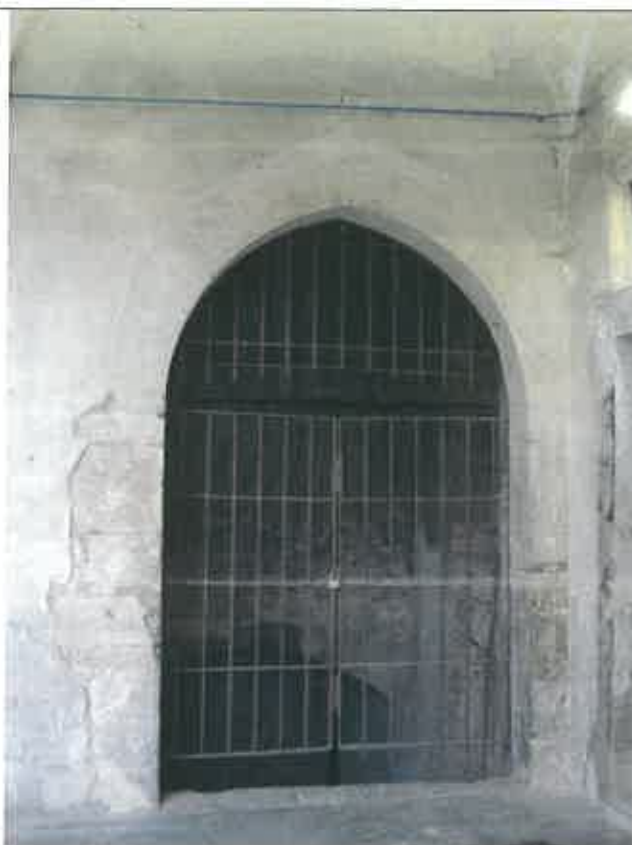
Vista del portale in pietra, in questo caso realizzato con conci squadrate di pietra tipo credaro, anche loro impropriamente verniciati Superfetazioni "s"
