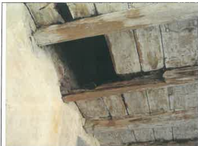
Particolare del solaio di sottotetto del loggiato del primo piano, con evidenti mancanze e fenomeni di marciscenza localizzati del legname.
