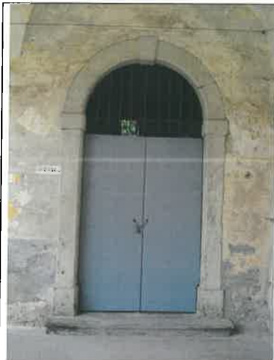
Portone in pannello truciolato di legno realizzato come chiusura provvisoria di sicurezza per impedire l'accesso ai locali pericolanti
