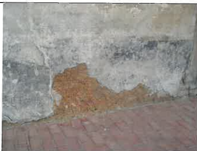
Altri rappezzi cementizi realizzati su affioramento roccioso
