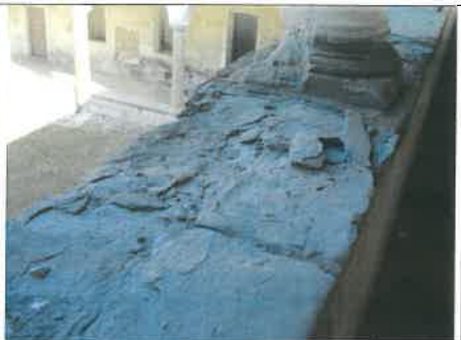
Particolare di una piana del muretto del portico del primo piano, si notano oltre agli ampi fenomeni di fessurazione e disgregazione Fessurazione "f", disgregazione scagliatura "di"
