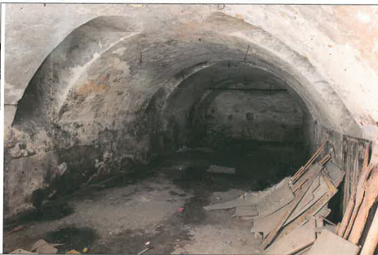
Vista d'insieme della volta a botte, con le lunette in corrispondenza delle aperture poste al piano terra
