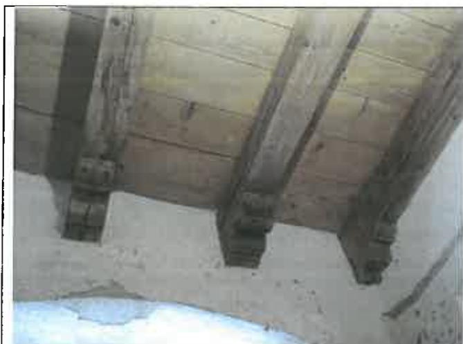
Particolare delle travi nella zona antibagno recuperate durante l'ultimo intervento sulla ex chiesa, con il dettaglio della mensolina con funzione decorativa ma anche di aumento della superfici di appoggio
