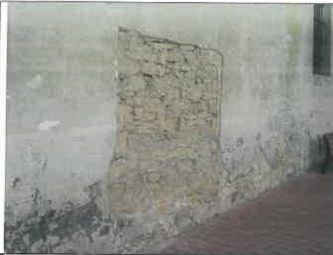
Una demolizione dell'intonaco realizzata probabilmente per valutare lo stato di consistenza della muratura
