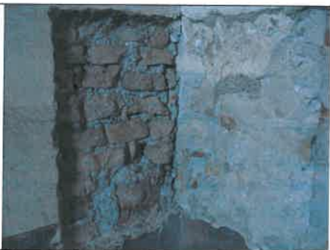
Altro particolare di murature non ammorsate, a sinistra era già mancante l'intonaco, il saggio è stato esteso anche destra
