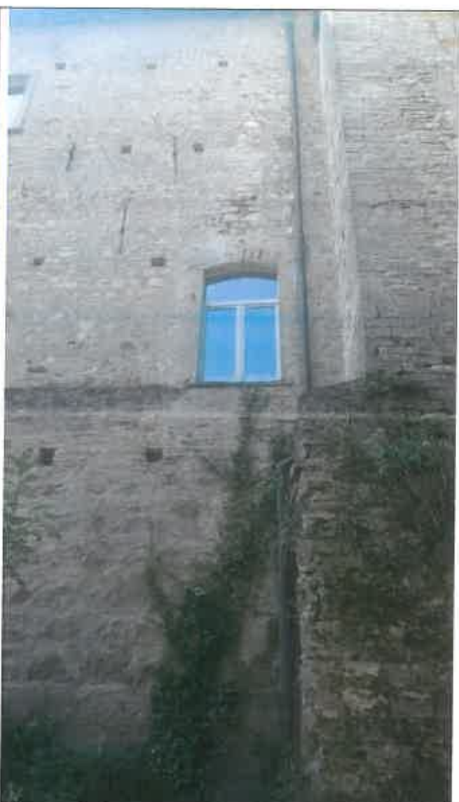
Altro particolare della zona immediatamente adiacente, in questo caso la situazione cambia, non c'è più una carenza delle malte ma quasi una sovrabbondanza con un effetto "raso/sasso" che ovviamente limita le infiltrazioni ed i ristagni d'acqua e quindi migliora lo stato di conservazione.
