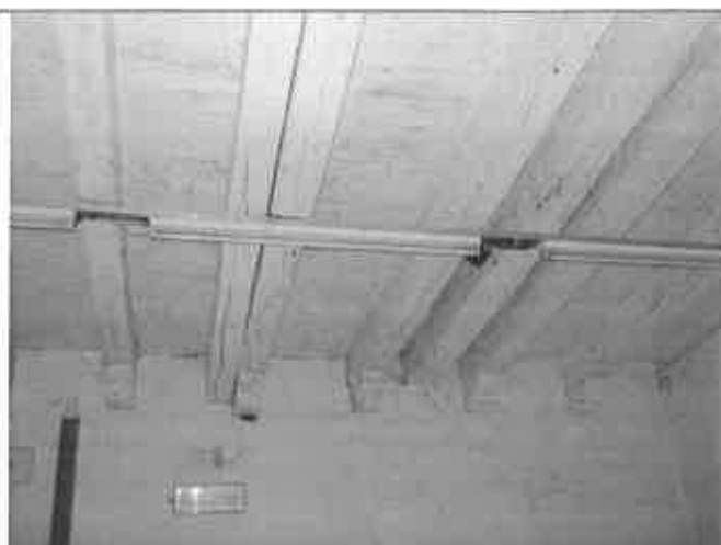
Particolare del medesimo solaio, dove sono state accostate delle travi di rinforzo a quelle originarie
