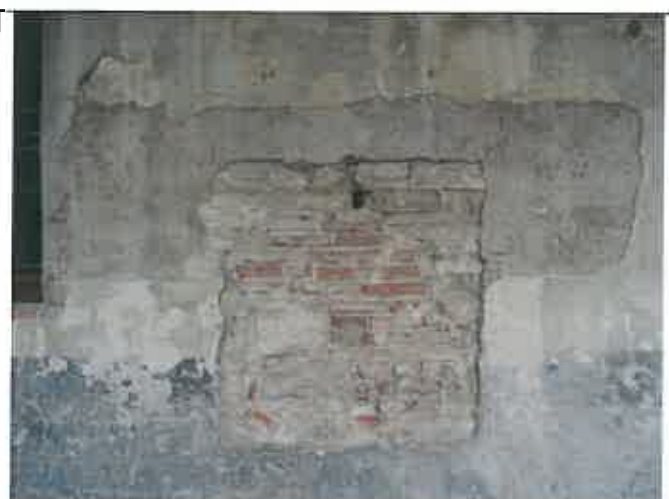
Campionatura già presente, fatta probabilmente per analizzare la struttura muraria, dove anche qui sono evidenti i differenti corpi di intonaco
