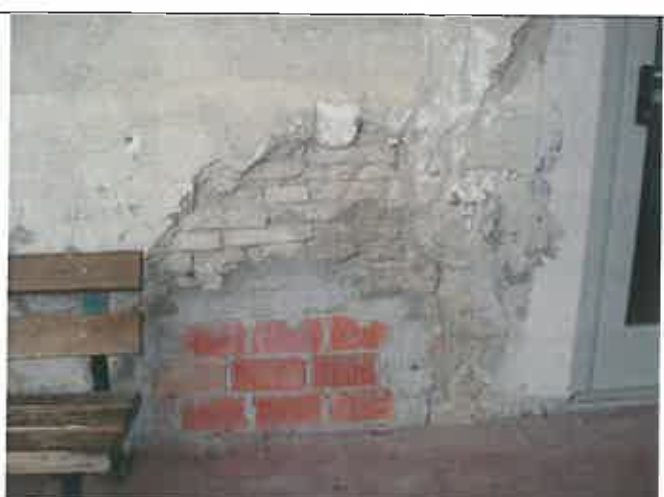
Non solo rappezzi cementizi ma anche interventi di ricostruzione con elementi in laterizio chiaramente impropri
