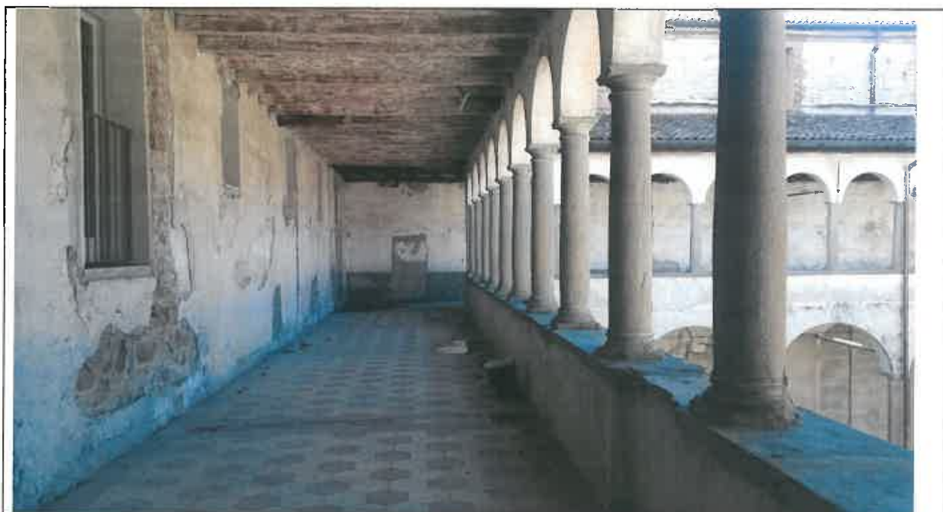
Vista del lato Est del primo piano sono evidenti sulla sinistra le lacune degli intonaci e la sovrapposizione di diversi corpi di intonaco
