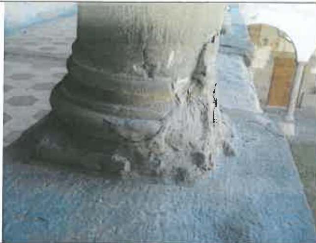
Particolare del basamento di una colonna al primo piano con ampia perdita della sezione, erosione, esfoliazione e fessurazioni, dovute al ristagno d'acqua. Erosione "er", esfoliazione "e"
