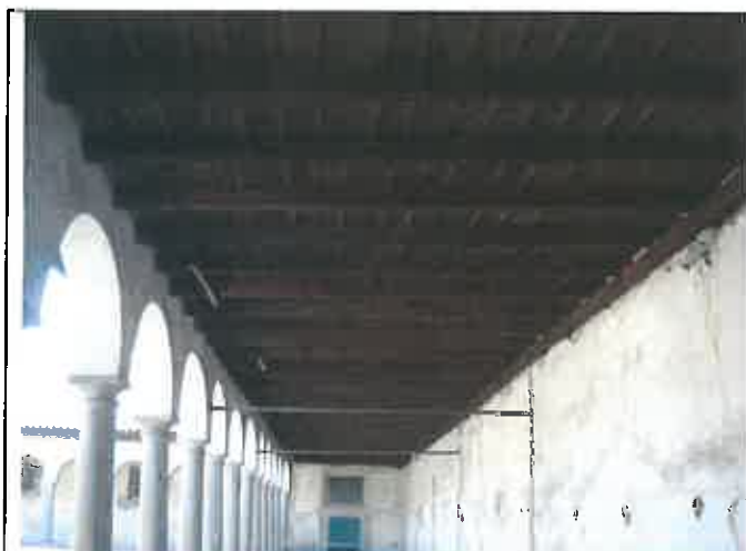
Vista del solaio in legno di copertura del porticato, lato sud, rifatto non molti anni fa
