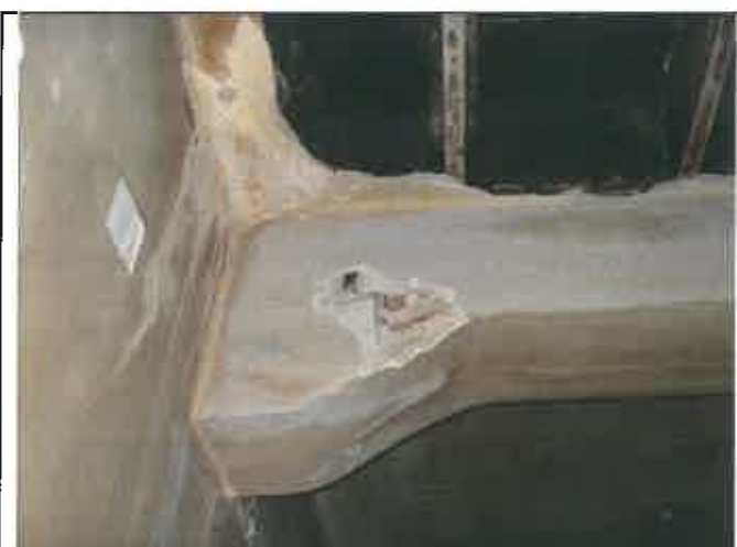
Particolare di una delle travi trasversali, del solaio a quota + 4,54 rivestita con assito di legno, rete metallica e poi intonacata, così come il soffitto in parte ceduto
