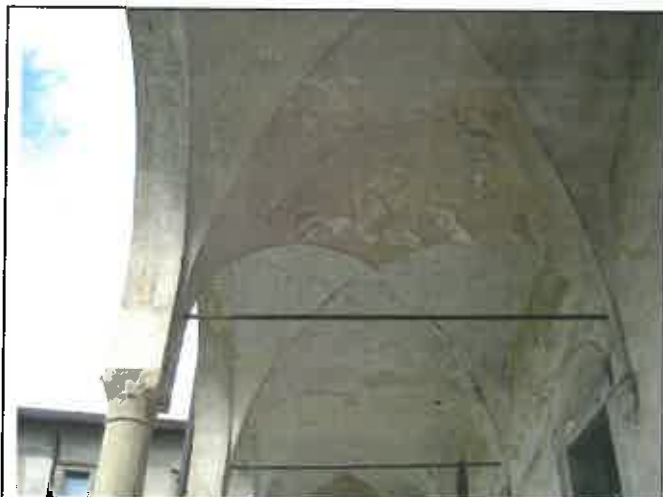
Vista della volta a crociera, è evidente la differenza di una zona dove è stato effettuato il discialbo di tutte le pitture e tinte a calce fino ad arrivare allo strato iniziale dell'intonaco a calce.
