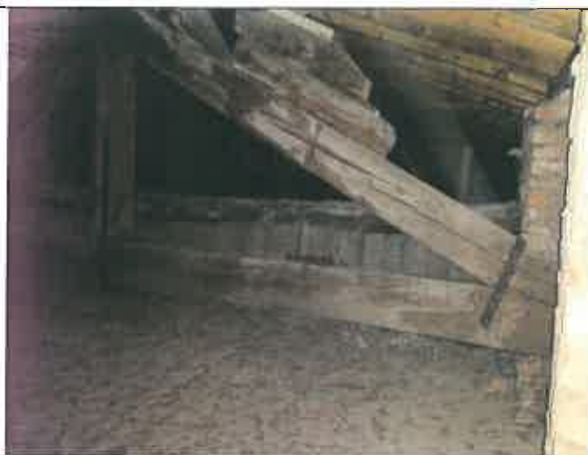
Particolare della capriata n° 5 dove è presente il salto di quota del sottostante solaio
