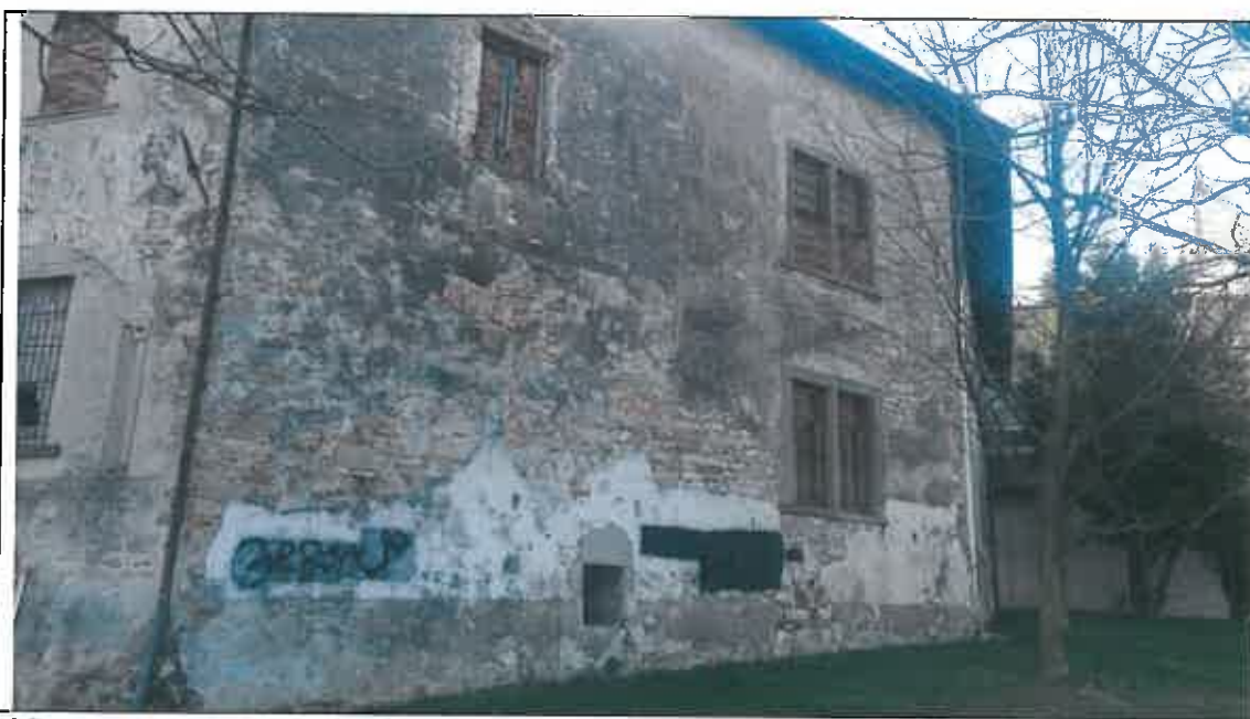
Vista del fronte esterno lato parco, si nota come alcune aperture risultino prive delle spalle, mentre altre presentano tutti gli elementi in pietra arenaria. Mancanze "m"
