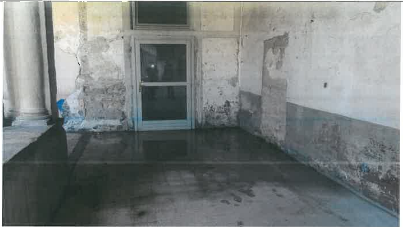
Vista del porticato del chiostro al primo piano, sono evidenti i fenomeni di infiltrazione dalla copertura, con ristagno d'acqua dovuto alla pendenza del solaio verso l'interno
