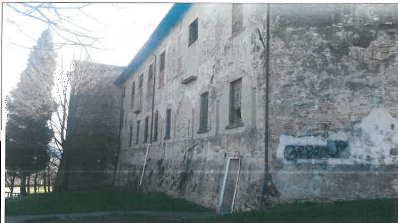
Vista d'insieme del fronte esterno lato nord, sono evidenti le superfetazioni realizzate per tamponare le aperture originarie, le finestre del piano primo e il loggiato corrispondente al piano terra del chiostro
