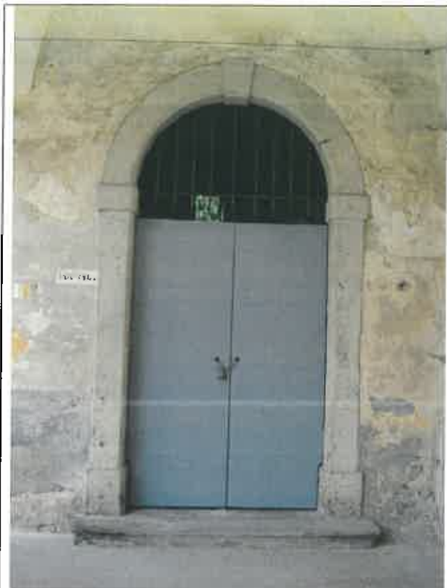
Portale d'ingresso della scala presente, realizzato in masselli di pietra arenaria impropriamente verniciati con smalti e vernici nel corso del secolo scorso. Superfetazioni "s"
