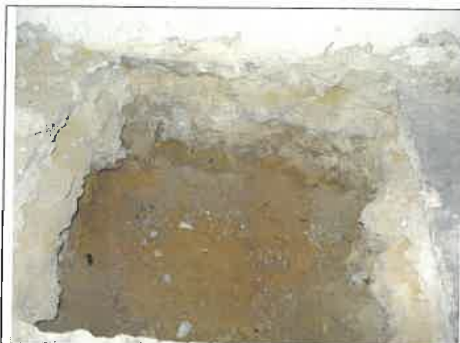
Particolare di un saggio effettuato per la verifica della presenza delle fondazioni, su un muro trasversale
