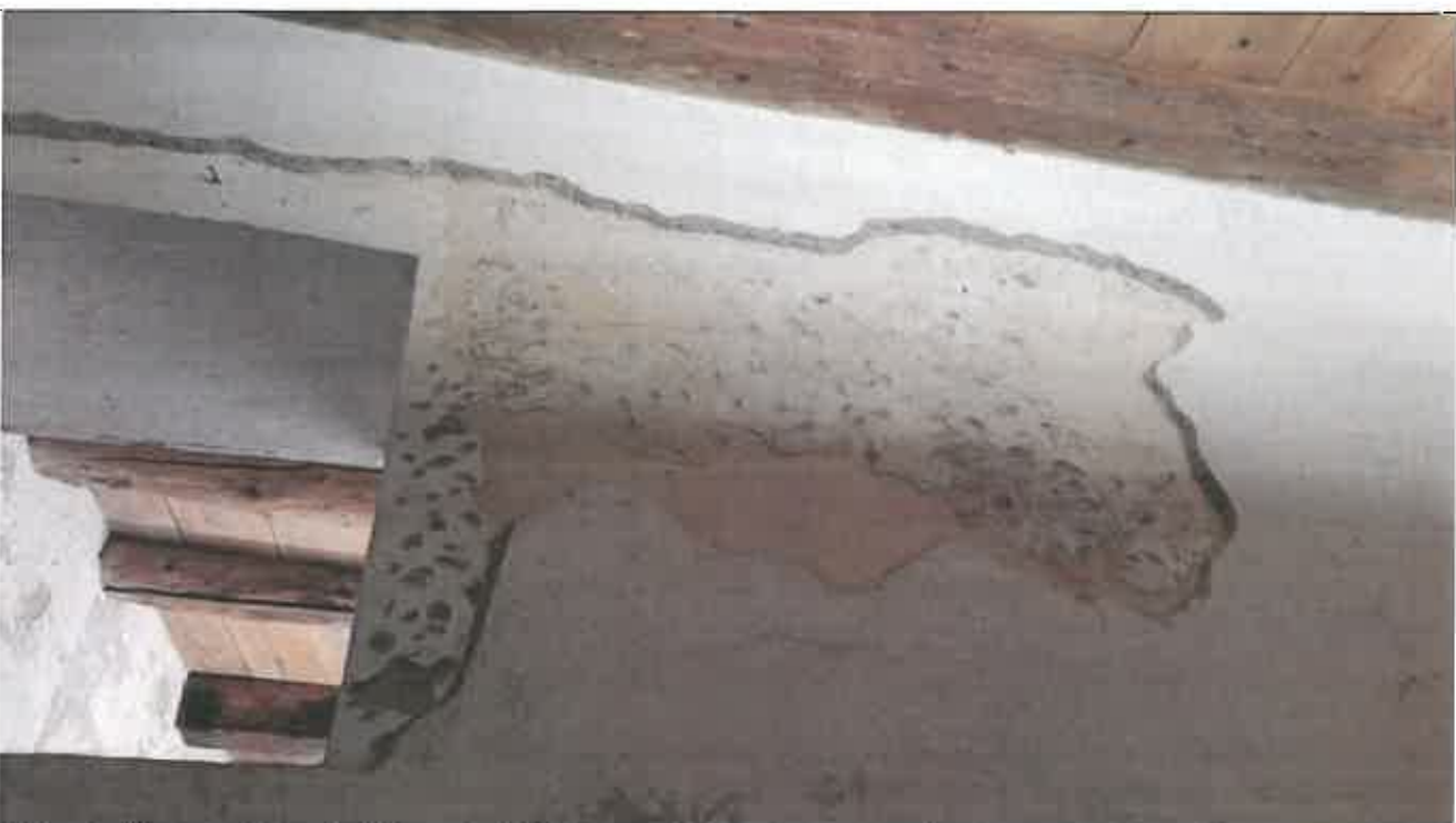
Vista degli intonaci interni dei bagni, rifatti durante l'ultimo intervento di recupero della ex chiesa, anche qui si nota il doppio strato di intonaco.
