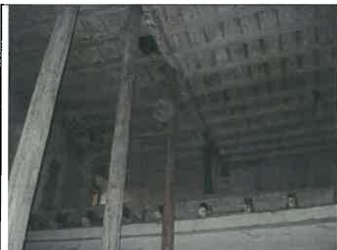
Particolare del solaio di sottotetto del corpo di fabbrica "A" lato piazzale completamente puntellato in mezzeria
