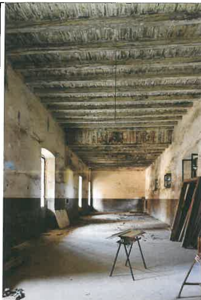
Vista del solaio in legno del sottotetto della grande sala posta al primo piano, del corpo di fabbrica "B", qui non sono presenti le mensoline sui travetti e inoltre è presente un anomalo salto di quota a + 9,40 m. di una porzione, che probabilmente stanno a significare un rifacimento dello stesso
