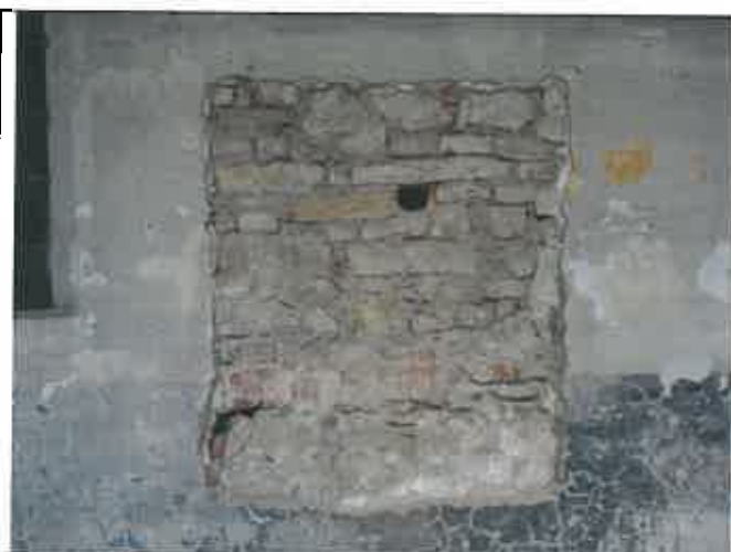
Foro effettuato su un saggio esistente per verificare la consistenza della muratura, si è riscontrato che non è stata realizzata a sacco
