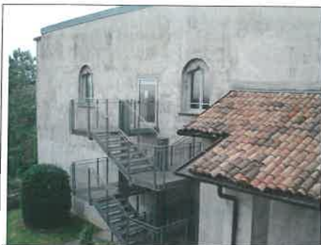
Vista dell'estremità del fronte Est, prospiciente il giardino esterno rialzato rispetto al parco. E' evidente la natura prettamente cementizia della malta utilizzata, totalmente priva di uno strato di finitura e di una tinta pittorica
