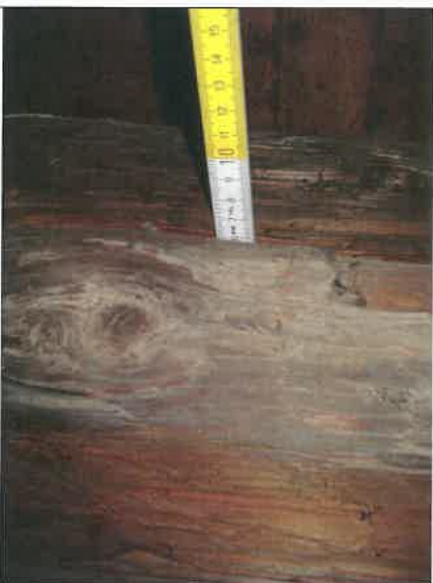
Particolare di una fessura presente in una trave di colmo
