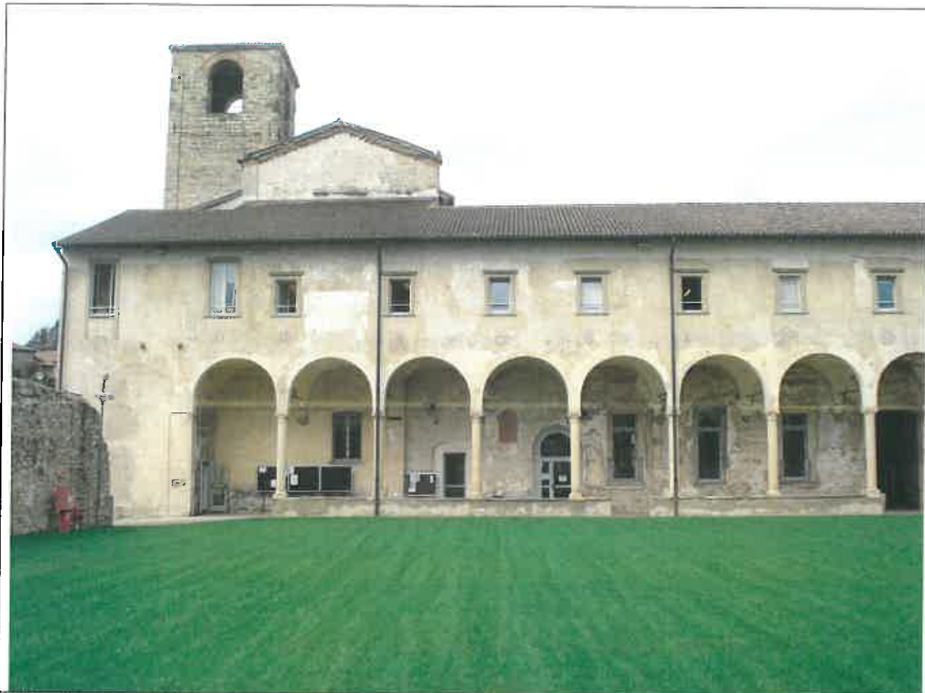
Vista d'insieme del fronte E, nella parte alta sotto gronda si evidenzia la fascia di intonaco cementizio realizzato nell'ultimo intervento per il rifacimento completo della copertura della biblioteca.
