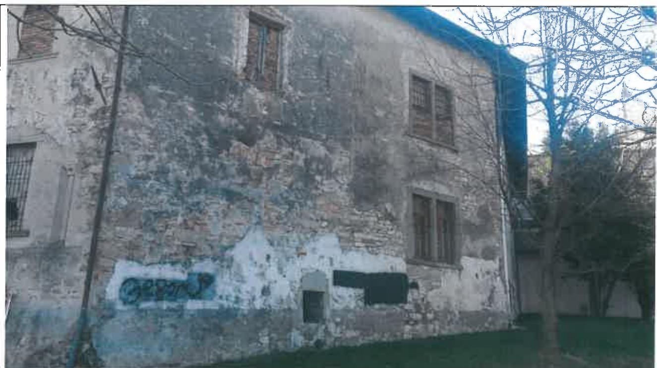
Vista d'insieme del fronte esterno lato nord-ovest, posto in diagonale per il collegamento dei lati nord e ovest, presenta minori aperture al piano terra ripristinato, per la realizzazione dei bagni a servizio della ex chiesa, al piano primo tamponate con superfetazioni in mattoni pieni
