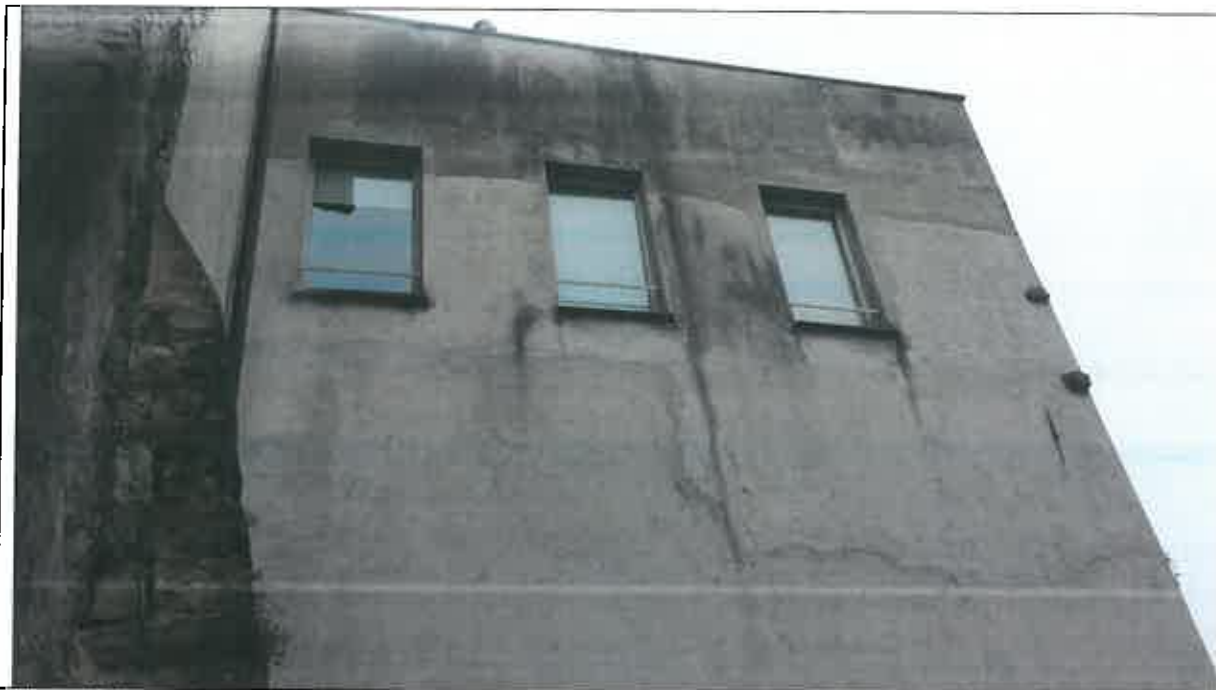
Vista della parte terminale del fronte est, dove è presente la grande terrazza, allo spigolo nord-est, anche qui gli intonaci presentano la stessa connotazione materica e la stessa scarsa qualità esecutiva
