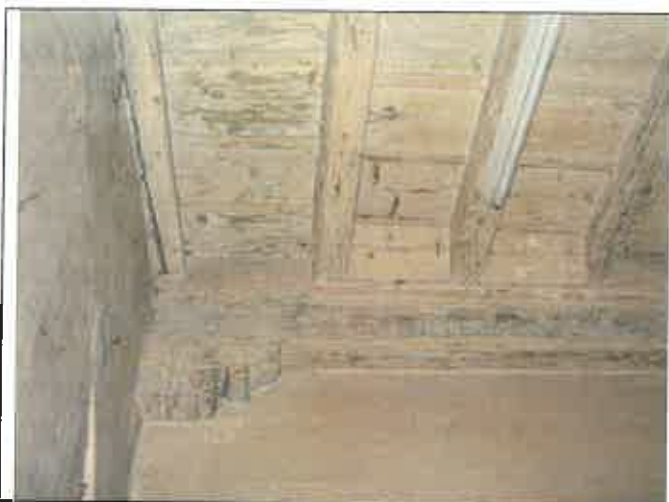
Particolare di un tamponamento in mattoni pieni posto in corrispondenza di una trave trasversale
