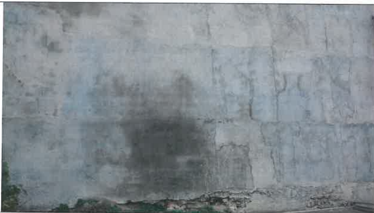
Particolare della parte bassa del medesimo fronte, dove i problemi di umidità di risalita sono amplificati dalla caratteristica materica del materiale cementizio,
