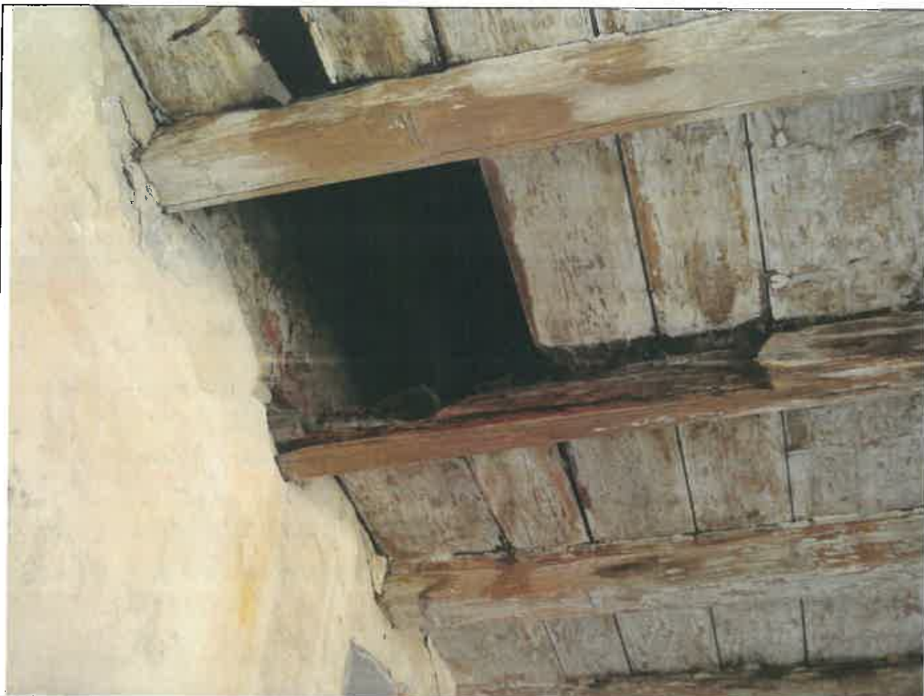
Particolare del medesimo solaio, in questo caso abbiamo la mancanza localizzata del tavolato con estesi fenomeni di marciscenza dei travetti, tali da renderne necessaria la sostituzione
