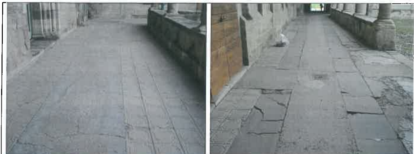
Vista del lato adiacente il chiostro maggiore, anche qui abbiamo piastrelle in cemento e battuto di cemento
