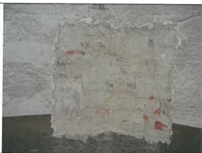
Particolare dell'incrocio tra muratura longitudinale e trasversale per la verifica dell'ammorsamento in questo caso buono
