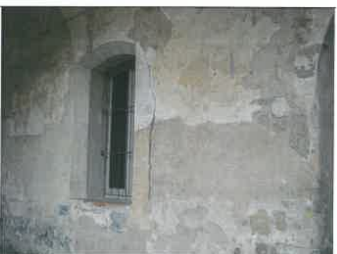
Vista della parte terminale del lato est impropriamente intonacata, sebbene si legga la presenza sottostante di pietra squadrata probabilmente realizzata per essere lasciata a vista
