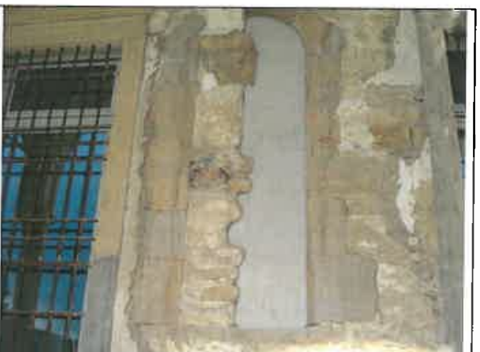
Chiusura di un'apertura intonacata con malta cementizia
