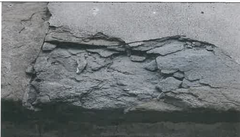
Particolare di un'altra piana al primo piano, oltre ai fenomeni di fessurazione e disgregazione, notiamo la presenza di ricostruzioni improprie con malta cementizia, che chiameremo superfettazioni cementizie. Disgregazione scagliatura "di", superfettazioni cementizie "sc"
