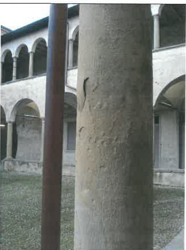
Particolare di una colonna con fenomeni di esfoliazione "e"
