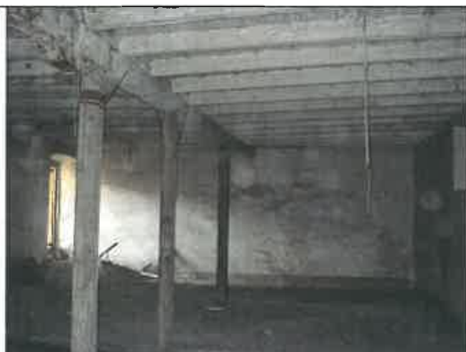
Altro particolare del medesimo solaio, sostenuto da puntelli provvisori, a seguito del cedimento strutturale
