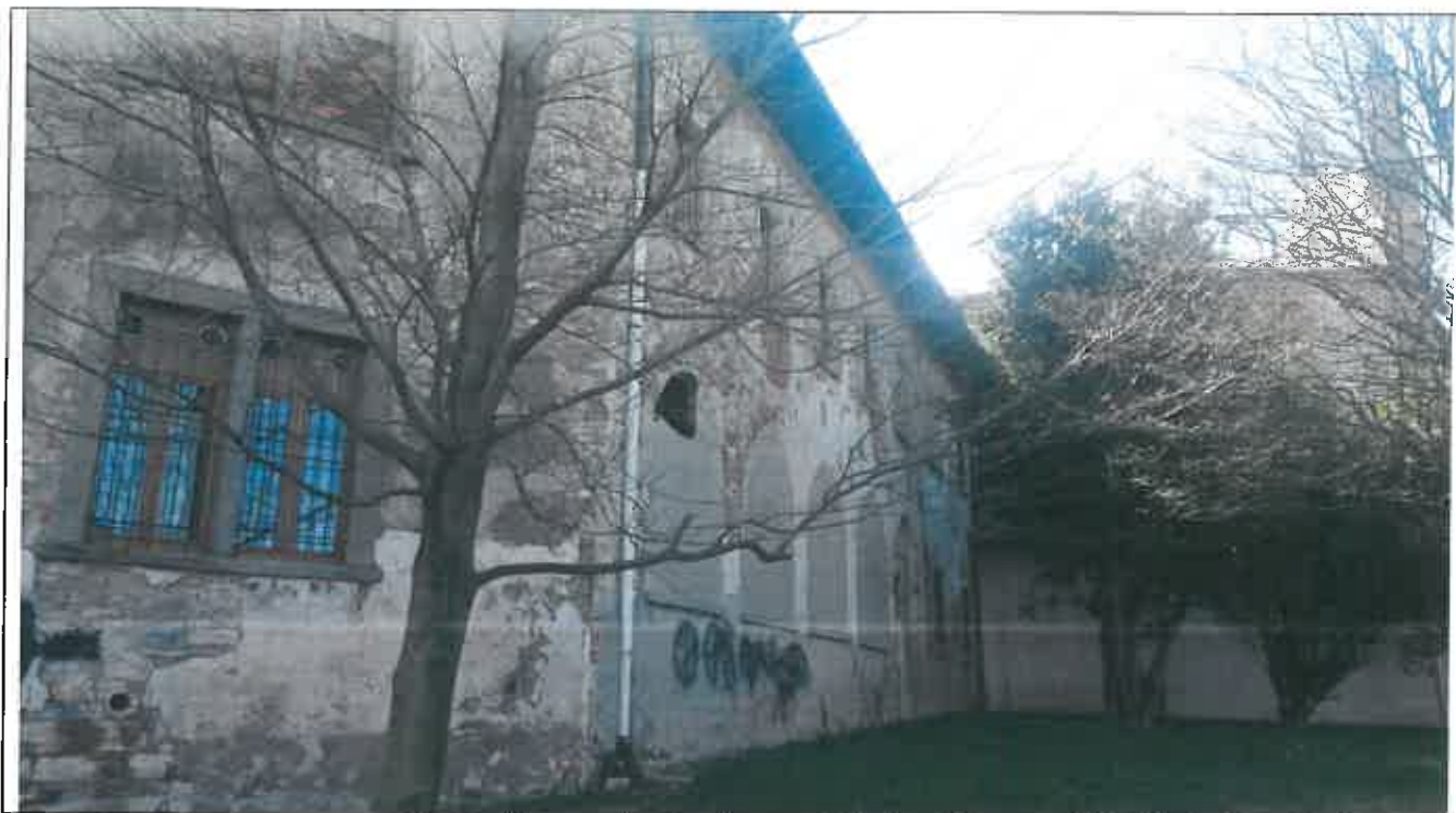
Vista d'insieme del fronte esterno lato ovest, si notano subito la chiusura dei bellissimi archi di epoca medioevale a sesto acuto, con prisme di cemento, la zoccolatura con intonaco cementizio, le grandi mancanze di intonaco nella parte alta inframmezzata con lacerti di intonaco antico
