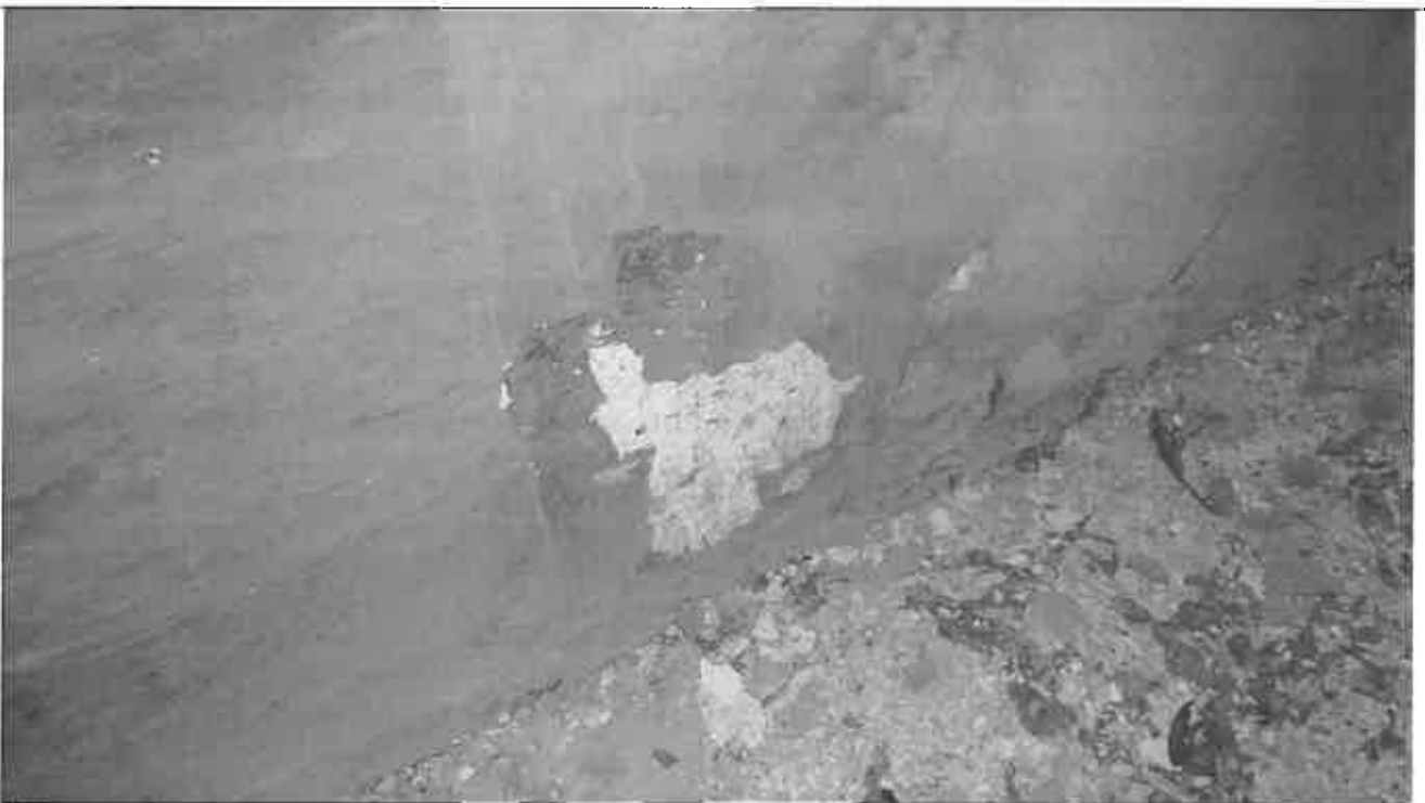
Altro particolare in questo caso si notano i numerosi strati di ridipinture a tempera presenti in molti ambienti
