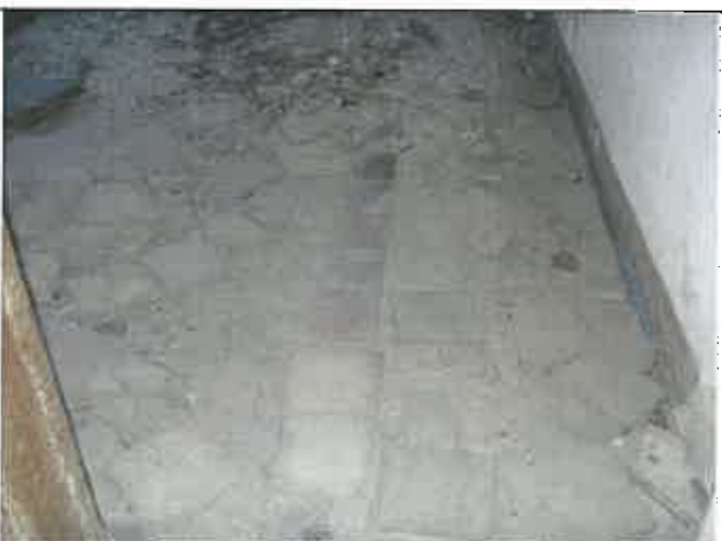
Pavimentazione in marmette 20x20 totalmente sconnessa in alcuni ambienti del primo piano
