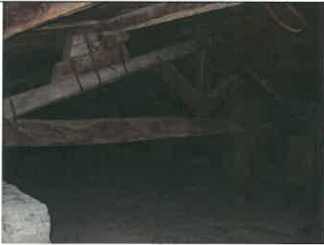
Vista della capriata n° 3 si nota la distanza del solaio sottostante, probabilmente in quanto rifatto in epoca recente, per il crollo parziale dello stesso.
