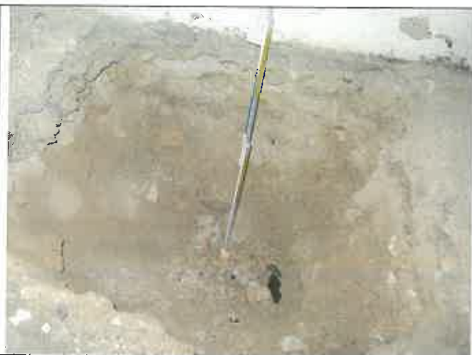
Altro particolare di un saggio effettuato per la verifica della presenza delle fondazioni su un muro longitudinale
