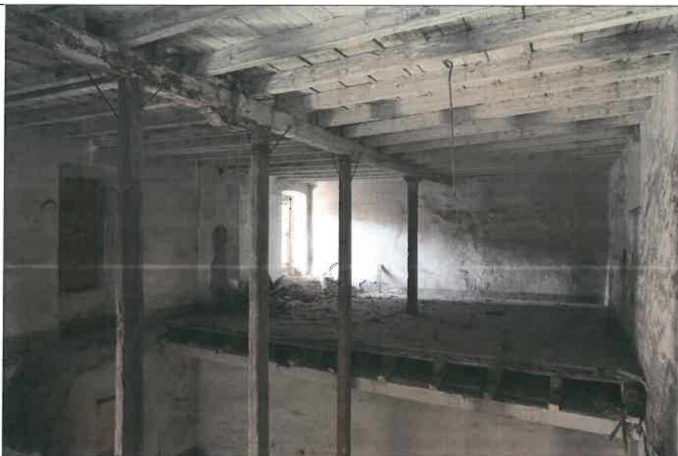
Vista d'insieme del corpo di fabbrica "A" lato piazzale dove c'è stato il cedimento strutturale di una grande porzione del solaio, tanto da rendere necessarie opere di puntellamento che partono dal piano inferiore e che poggiano pericolosamente sulla volta sottostante. Da questa immagine si vede l'andamento longitudinale del vecchio solaio, sostenuto dalle grosse travi in legno di epoca medioevale.
