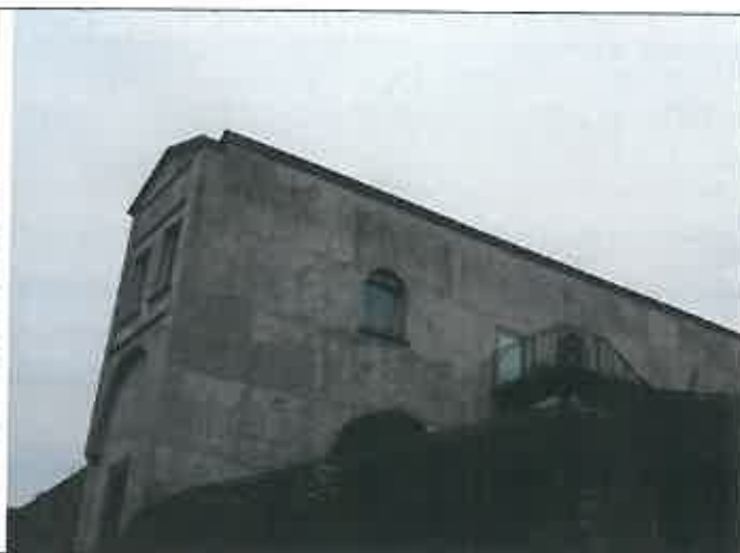
Altra vista del medesimo fronte, da qui risulta evidente anche la scarsa qualità esecutiva che mette in risalto tutte le riprese dell'intonaco in fase esecutiva
