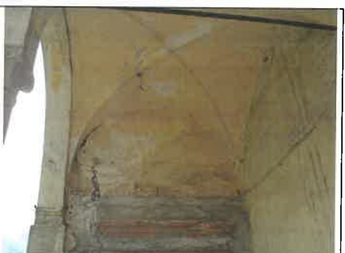
Particolare della testata e dell'ultima volta del fronte E, sono evidenti i fenomeni di fessurazione presenti sugli intonaci
