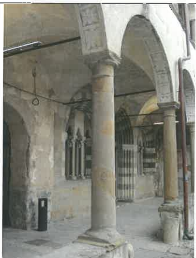
Colonne del porticato a piano terra, in pietra arenaria locale di colore marrone con erosione della parte bassa esterna maggiormente esposta. Erosione "er"
