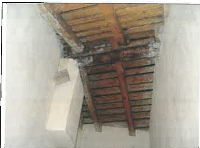
Particolare della struttura della copertura, realizzata in legno, con manto costituito da assito aperto, onduline fibrobituminose e coppi
