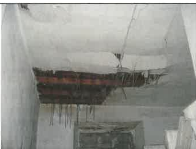
Particolare del solaio della parte stretta, a quota + 7,45 intonacato con struttura in cannucciato.
