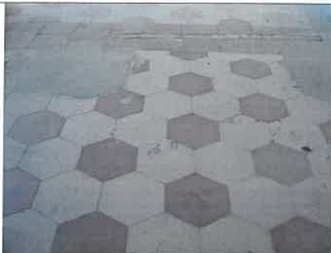
Vista della pavimentazione in mattonelle esagonali tipica degli anni '20, presente al primo piano sul lato sud del porticato
