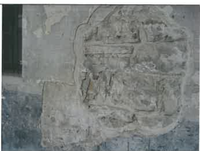
Particolare di una lacuna dove sono state effettuate delle improprie sigillature salvabordo
