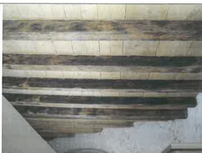
Altro particolare della zona bagni, anche qui le travi sono state totalmente recuperate, però probabilmente sono di epoca successiva in quanto non presentano la mensolina all'appoggio
