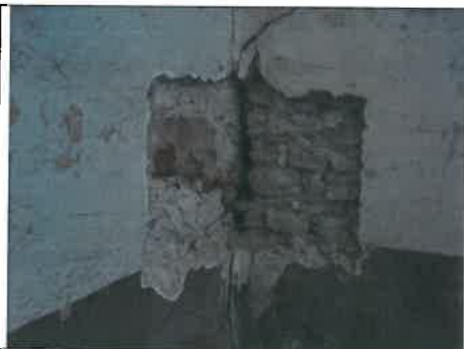
Altro particolare per verificare l'ammorsamento delle murature, in questo caso risulta evidente che le murature non sono coeve tra di loro
