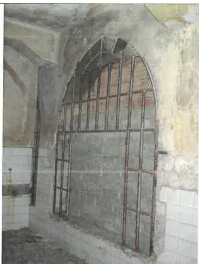
Altro tamponamento di un'altra finestra ad arco, in questo caso in un ambiente adibito a cucina
