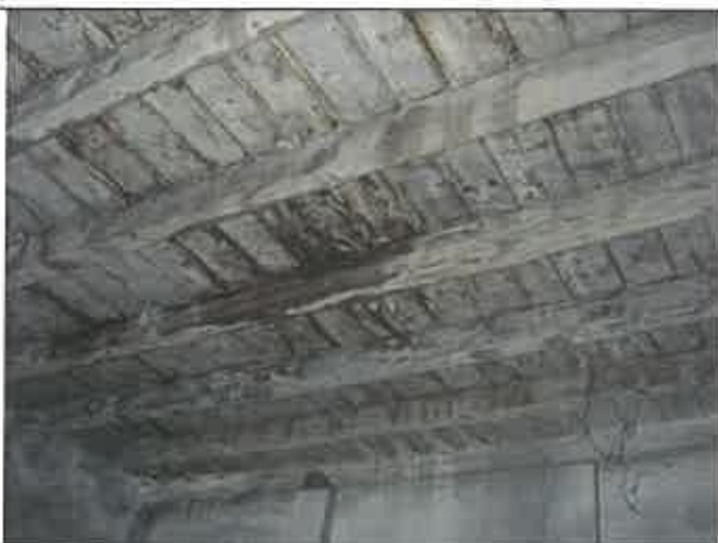
Vista sempre del solaio in legno del sottotetto, nella zona di raccordo tra i due corpi di fabbrica, sono evidenti fenomeni localizzati di infiltrazione
