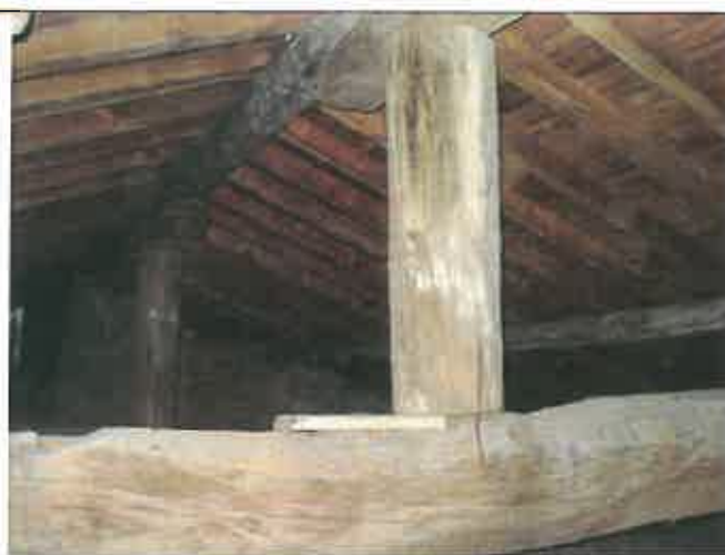
Particolare di una trave di grosse dimensioni e ottima qualità, che sostiene un puntone in corrispondenza del colmo, che di fatto fa le funzioni di una capriata
