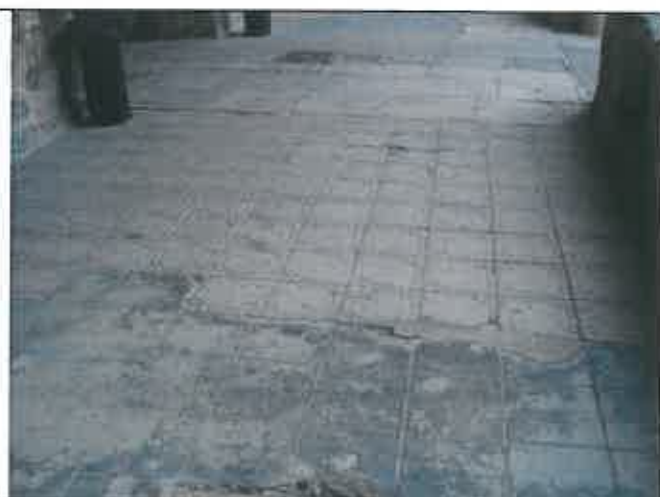
Particolare in cui si evidenzia l'eterogeneità delle pavimentazioni, frutto di differenti interventi manutentivi
