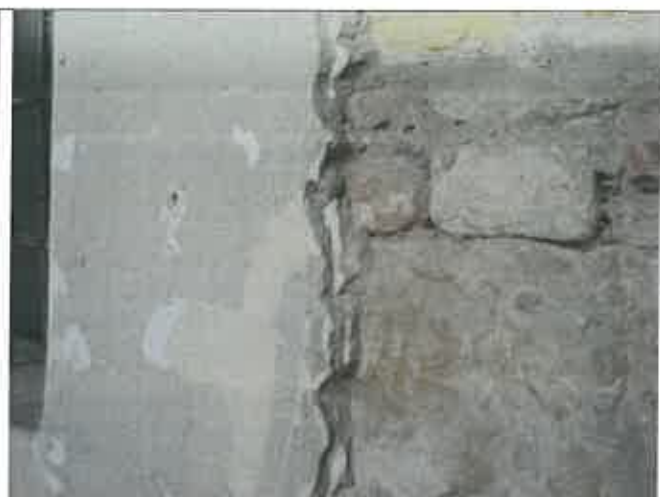
Dettaglio di una porzione adiacente una finestra con in evidenza i due differenti corpi di intonaco
