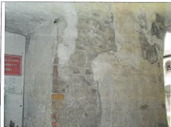
Particolare dell'ingresso a piano terra del chiostro, dove anche qui sono evidenti le lacune e le sovrapposizioni di diversi corpi di intonaco
