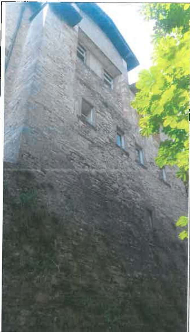
Particolare del fronte nord lato parco, si nota come la muratura non sia intonacata, in questo caso è evidente la carenza della malta di allettamento tra i diversi conci di pietra.
