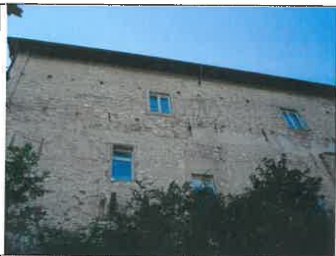
Vista della parte terminale del fronte nord lato parco, con prevalenza di tessitura muraria in pietra, intervallata con mattoni e lacerti di intonaco
