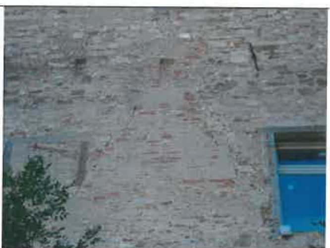
Particolare di una zona oggetto di cuci-scuci con mattoni pieni, con sigillature improprie di malta cementizia, presente anche sui contorni delle aperture
