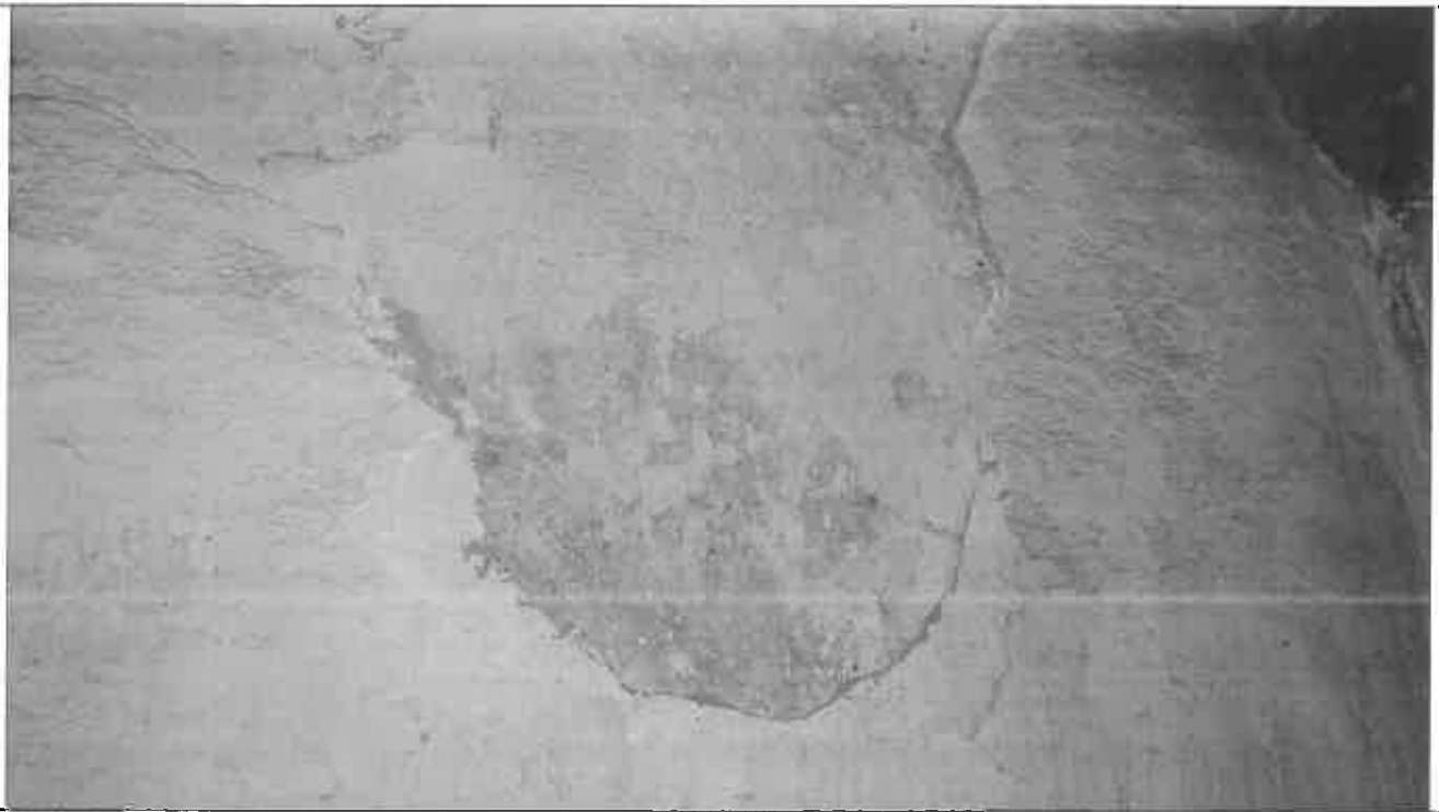
Particolare della sovrapposizione di intonaci di epoche differenti
