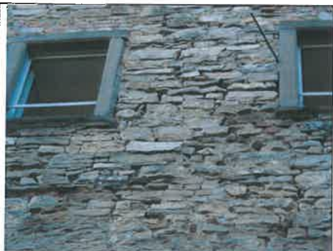
Particolare di una zona con evidenti mancanze delle malte di allettamento, i contorni delle finestre in pietra
