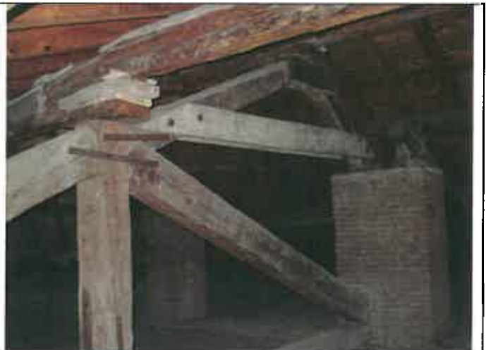
Particolare della capriata n° 4, lo stato di conservazione è buono, anche se la qualità costruttiva dei particolari non è certamente delle migliori.
