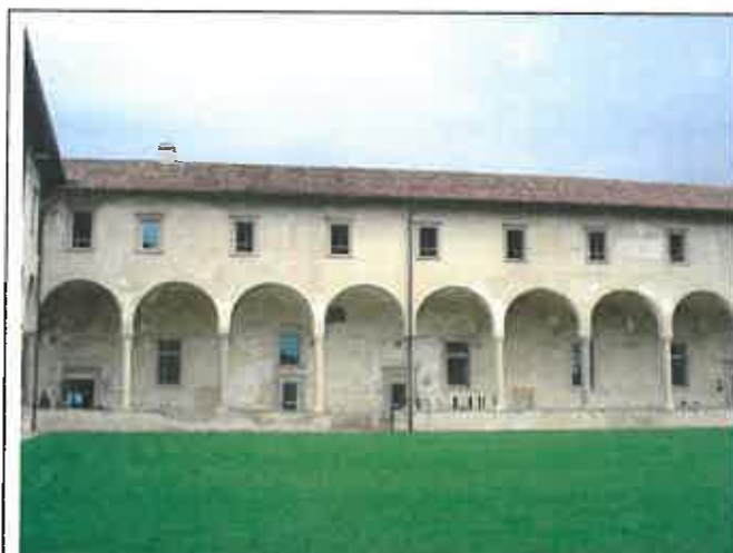
Vista della semi porzione di sinistra del fronte F, in questo caso non è presente la fascia in quanto la struttura del tetto probabilmente non è stata modificata nell'intervento di ristrutturazione
