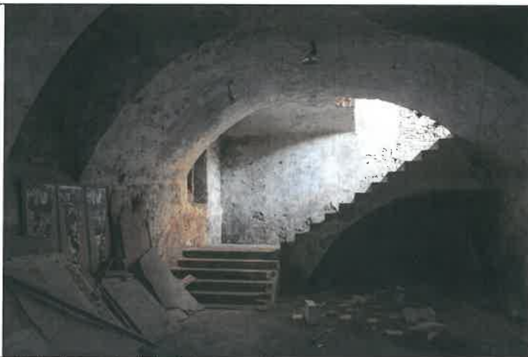
Vista della scala di collegamento al piano interrato, poggiante su un arco rampante
