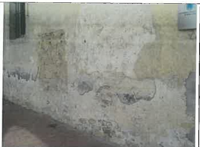
Sono evidenti le mancanze e distacchi nella parte bassa, i campioni realizzati e la presenza degli intonaci antichi a base calce nella parte più alta
