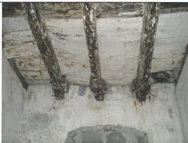
Altro particolare di un ambiente laterale sempre del corpo di fabbrica "A" lato piazzale dove sono evidenti i cedimenti strutturali localizzati, legati alla marciscenza dei travetti, provocati da vecchie infiltrazioni d'acqua dalla copertura
