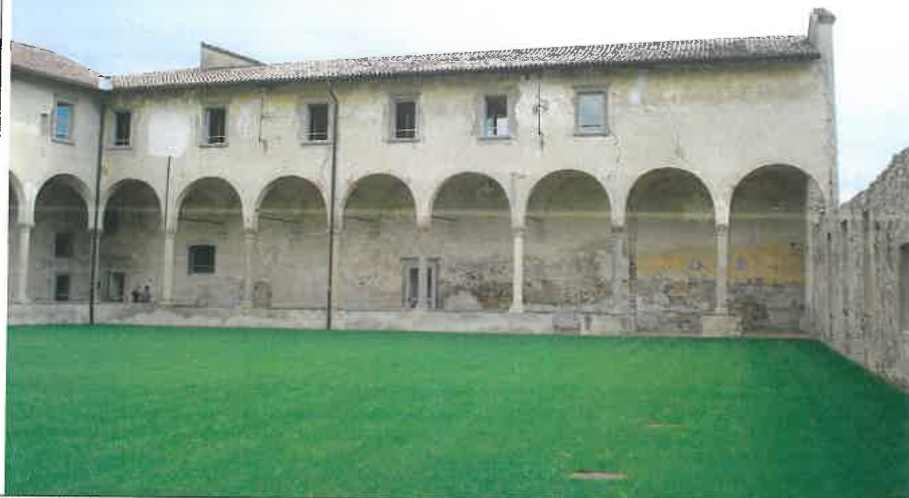
Vista d'insieme del fronte G, anche qui valgono le medesime considerazioni fatte per il fronte F, con la presenza di un grosso rappezzo cementizio e un quadro fessurativo maggiore rispetto agli altri due fronti
