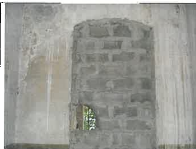
Tamponamento esterno in prisme di cemento
