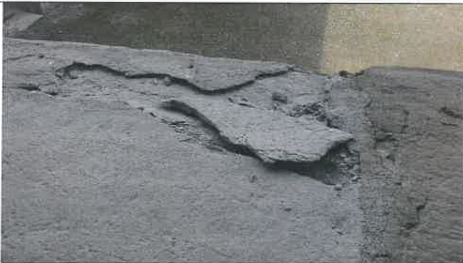
Particolare di un'altra piana al primo piano, con fessurazioni profonde che hanno portato alla parziale disgregazione del materiale, anche qui notiamo la differenza tra i colori del materiale, frutto di sostituzioni. Disgregazione scagliatura "di"
