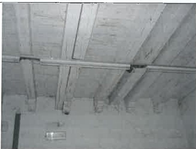
Vista del solaio degli ambienti interni a quota + 4,00 m. del corpo di fabbrica "B" lato parco, verniciato probabilmente per un riutilizzo provvisorio di alcuni ambienti del piano terra. Sono comunque evidenti le Fessurazioni e l'imbarcamento dei travetti
