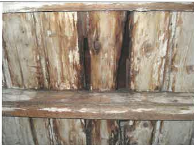
Particolare di un travetto notevolmente deformato e probabilmente anche di sezione non idonea, e del soprastante assito con ampi fenomeni di marciscenza
