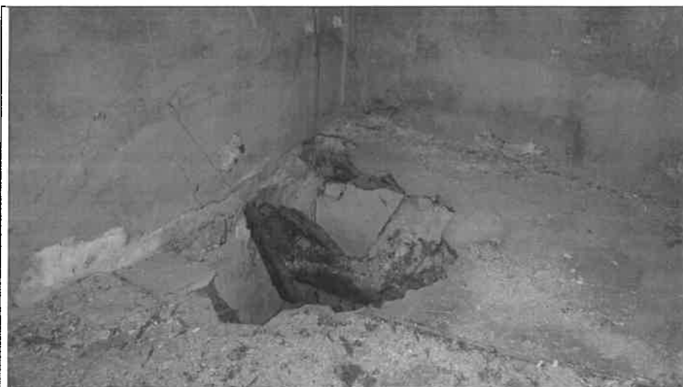
Particolare di un cedimento strutturale localizzato del solaio a quota + 4,00 dovuto alla marciscenza della trave in legno all'appoggio, probabilmente per vecchie infiltrazioni d'acqua dal tetto
