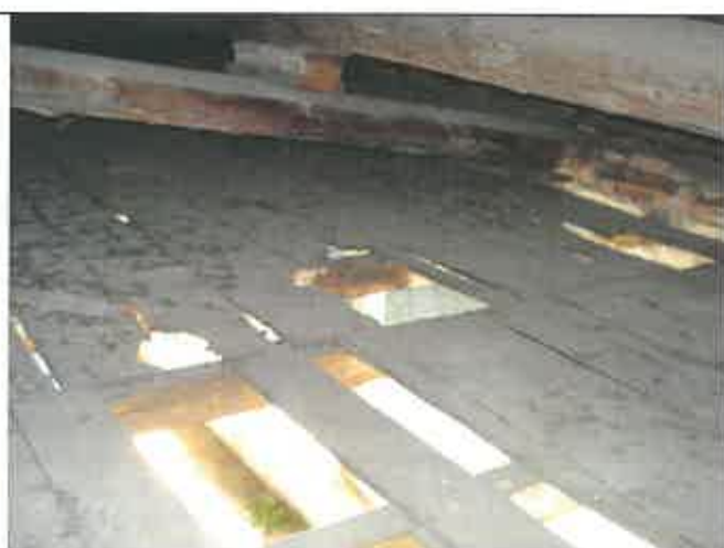
Particolare del medesimo solaio, mentre il lato sud è stato rifatto ex novo gli altri tre lati, non sono stati toccati e presentano notevoli mancanze e fenomeni di marciscenza sia del tavolato che dei travetti
