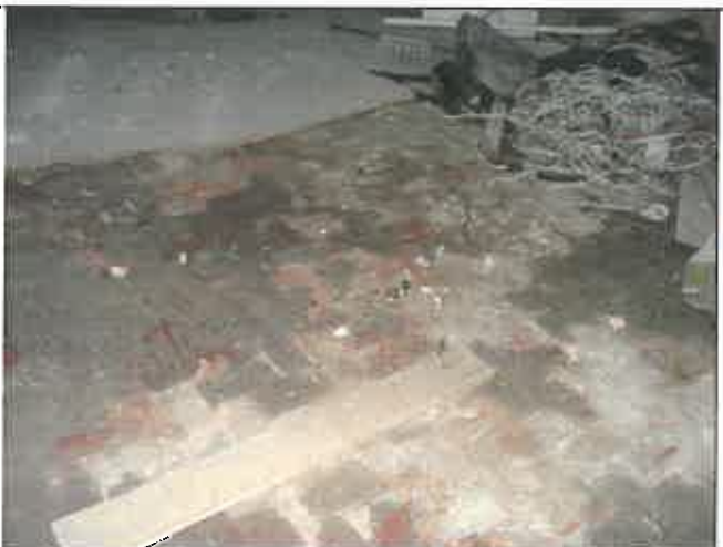
Pavimentazione in piastrelle di gres 6x12 in alcuni locali del piano terra
