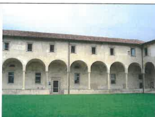
Vista della semi porzione di destra, sempre del fronte F, si notano le superfetazioni cementizie per chiudere le "tracce" per le tubazioni dell'impianto di illuminazione
