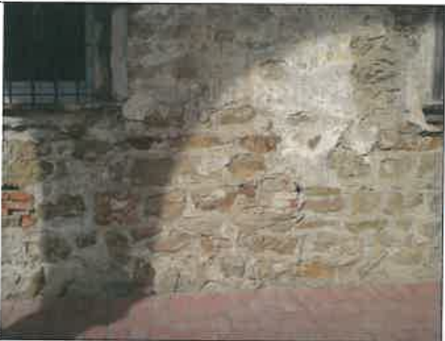
Muratura nella parte bassa, stilata con malta cementizia
