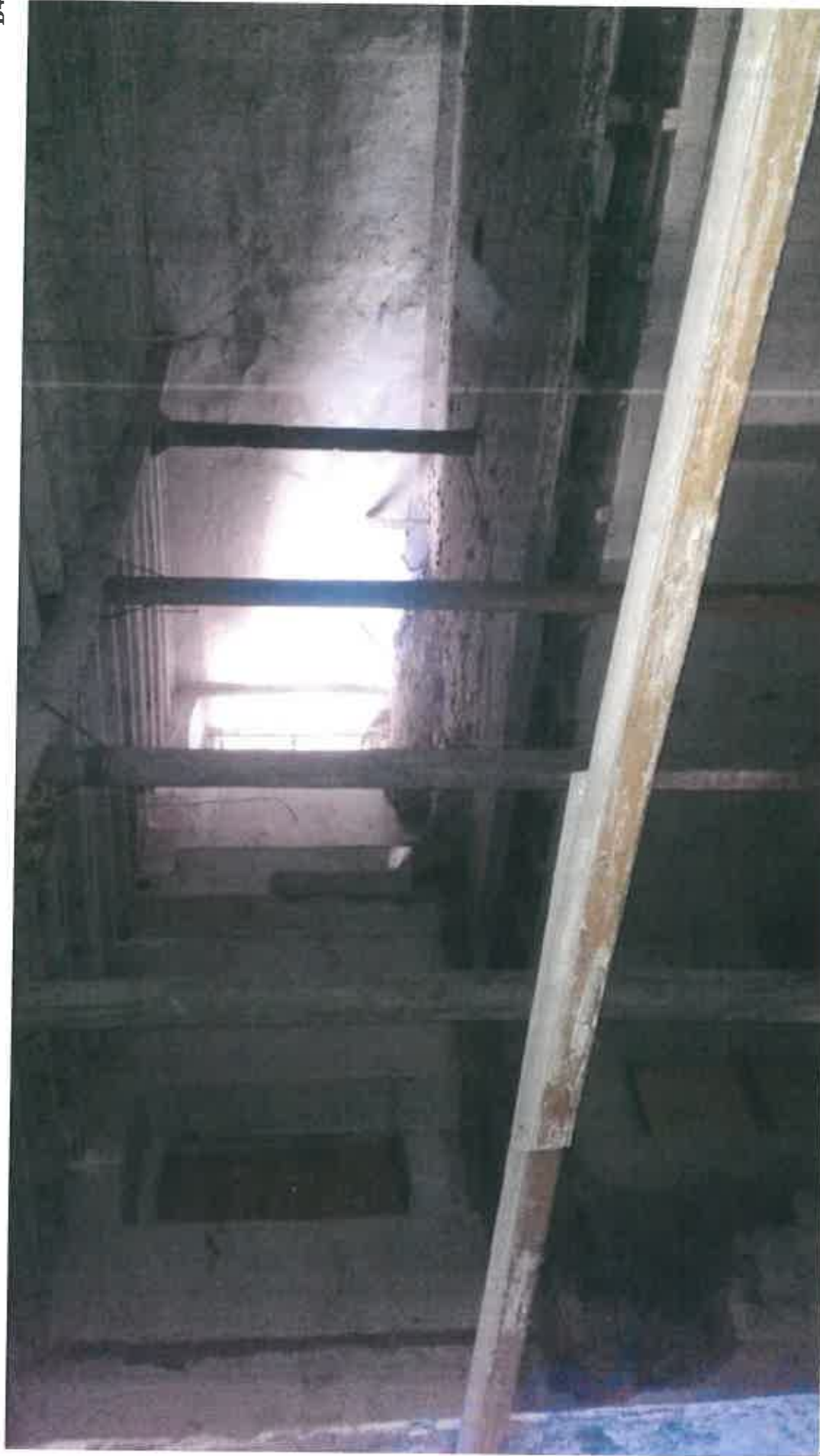
DETTAGLIO DEL CORPO DI FABBRICA A LATO PIAZZALE, DOVE C'E' STATO IL GROLLO PARZIALE DEL SOLAIO, E DOVE SI EVIDENZIANO I PUNTELLI IN LEGNO, CHE POGGIANO SULLA VOLTA SOTTOSTANTE, A SOSTEGNO DELLA TRAVE DI MEZZERIA DEL SOLAIO DI SOTTOTETTO, IN QUANTO I TRAVETTI IN LEGNO PRESENTI NO HANNO UNA LUNGHEZZA SUFFICIENTE A COPRIRE LA LUCE DEL SOLAIO
