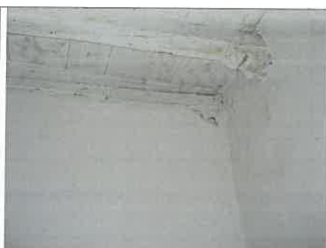
Altro particolare sempre di un tamponamento in mattoni pieni posto sotto un travetto
