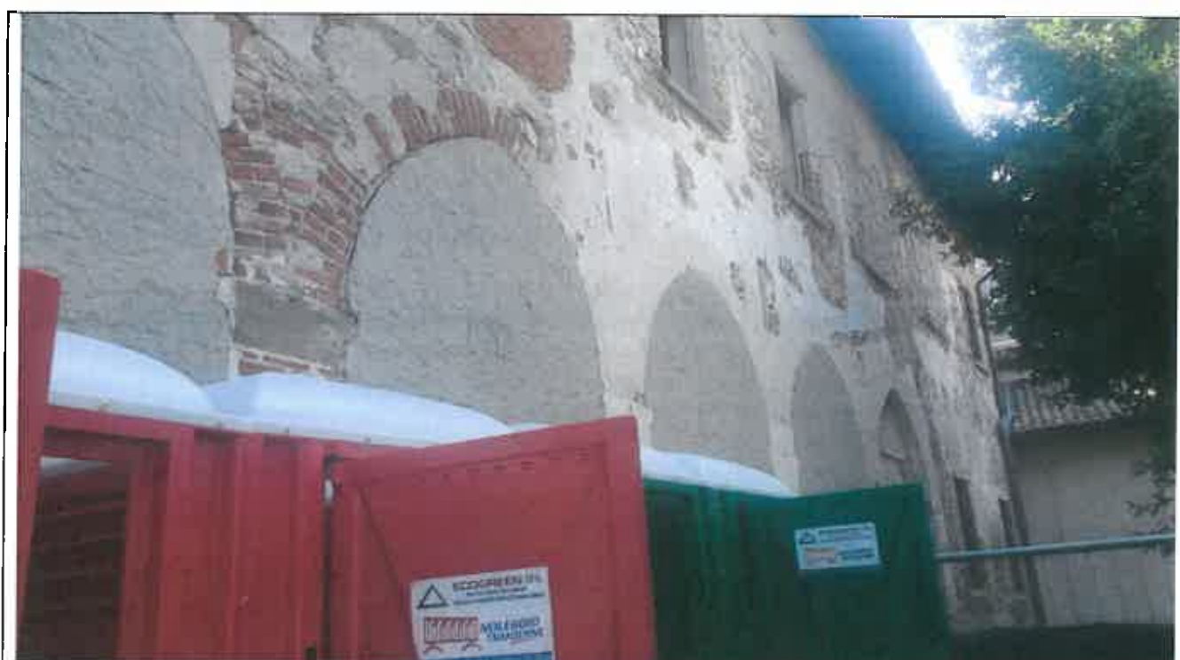
Particolare del fronte ovest, in cui si nota la grande disomogeneità dello stesso dovuto anche alla notevole presenza di elementi impropri
