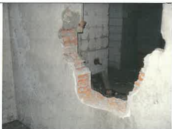
Divisorio interno in mattoni forati, particolare
