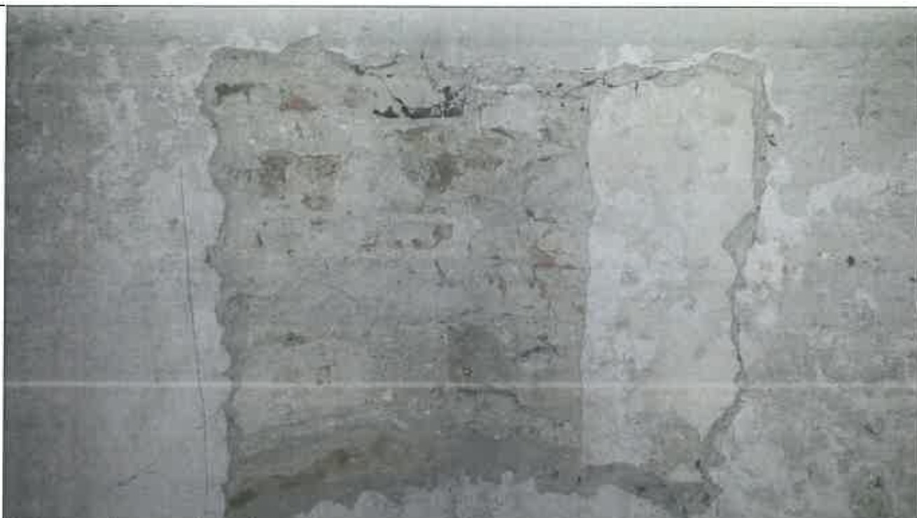
Particolare di un saggio realizzato in passato, probabilmente per valutare le condizioni della muratura e l'ammorsamento dei muri trasversali e longitudinali, in questo caso eseguita a regola d'arte, sulla destra si nota la presenza di un doppio strato di intonaco
