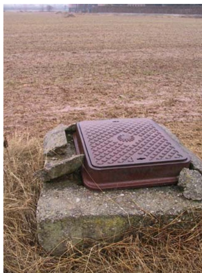
Foto 2: Zona 21, particolare del pozzetto di ispezione.
