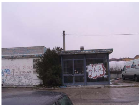
Foto 4: Zona 12, ex stazione di servizio adiacente via G. B. Moroni.
