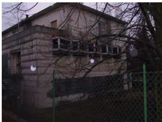
Foto 4: Zona 16, lato nord-ovest fabbricato esistente.
