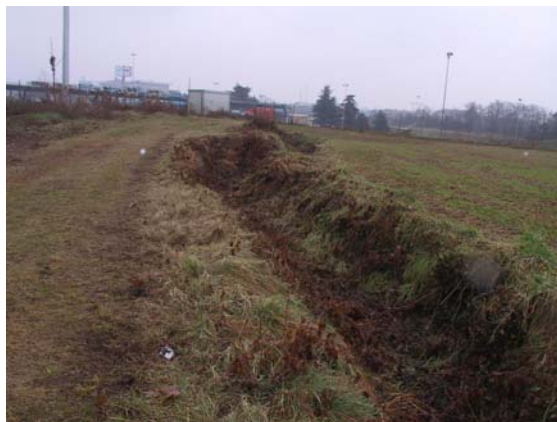
Foto 4: Zona 25, roggia sul lato sud-est
