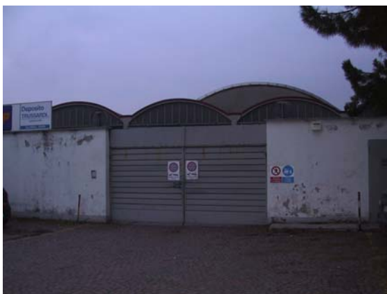
Foto 1: Zona 7, ingresso da via Autostrada.
