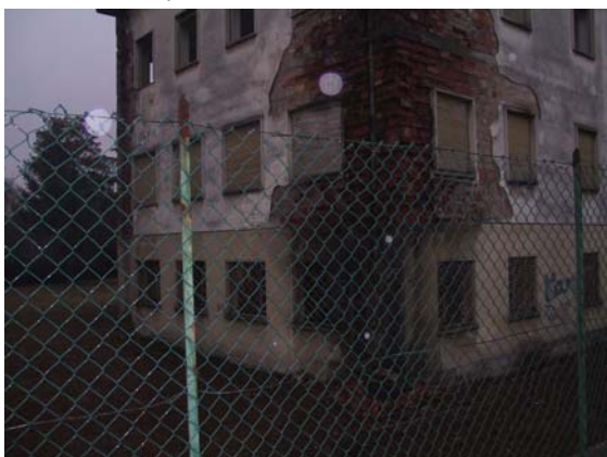
Foto 3: Zona 16, lato nord fabbricato esistente.
