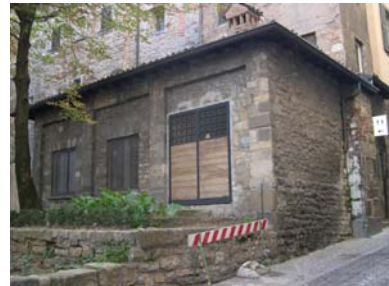
Cono di ripresa n. 14 Unità edilizia da rimuovere
