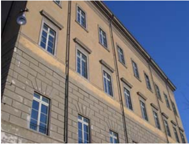
Cono di ripresa n. 6 Facciata su via Simone Mayr del Liceo Sarpi
