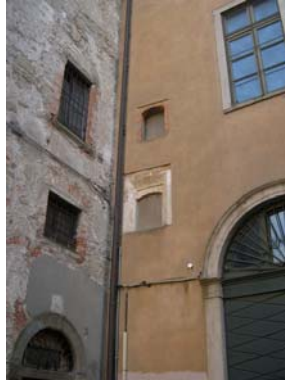
Cono di ripresa n. 8 Due nicchie sulla facciata dell'unità edilizia n.1
