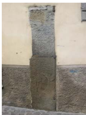
Cono di ripresa n. 12 Particolare della facciata dell'unità edilizia n.7
