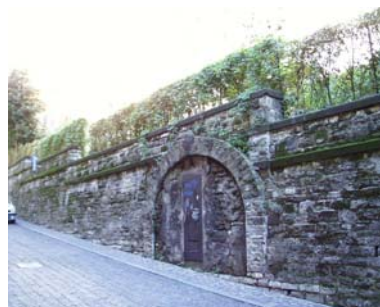
Cono di ripresa n. 19 Paramento murario da valorizzare e ingresso a rifugio antiaereo in via Porta Dipinta
