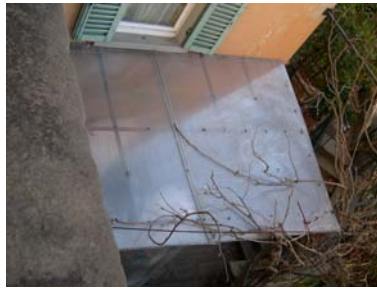
Cono di ripresa n. 5 Tettoia
