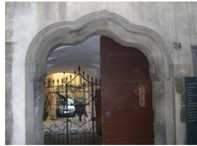
Cono di ripresa n. 10 Arco in pietra dell'unità edilizia n.5
