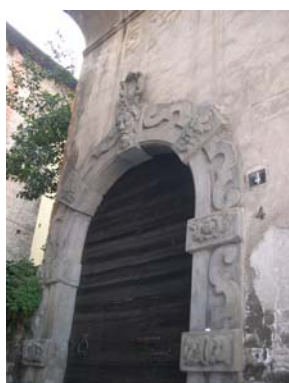
Cono di ripresa n. 16 Portale con stemma (unità edilizia n.7)
