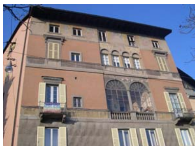
Cono di ripresa n. 7 Ordinamento architettonico dipinto sull'unità edilizia n.2
