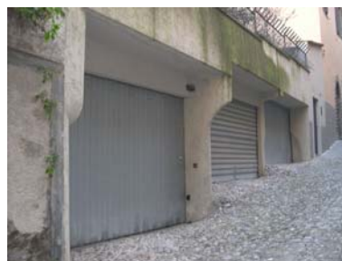
Cono di ripresa n. 17 Riconfigurazione del fronte e degli accessi carrali eliminando basculanti e c.a. a vista (unità ipogea n.2)
