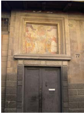
Cono di ripresa n. 11 Dipinto sopra il portone dell'unità edilizia n.5
