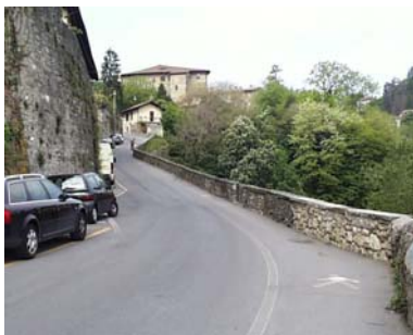
Cono di ripresa n. 21 Paramento murario da valorizzare in via Boccola
