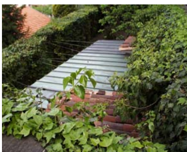
Cono di ripresa n. 14 Baracca (unità edilizia n.4) da rimuovere
