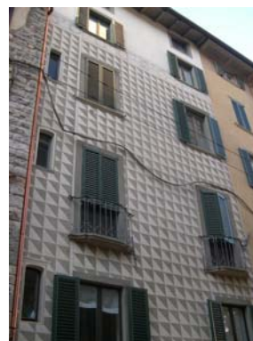
Cono di ripresa n. 22 Ordinamento architettonico dipinto conservato integralmente sull'unità edilizia n.3
