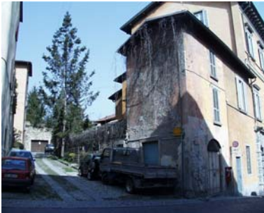
Cono di ripresa n. 3 Intonaco antico sulle facciate delle unità edilizie n.1 e n.3
