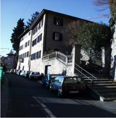
Cono di ripresa n. 1 Scaletta e ingresso da salvaguardare
