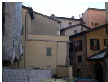
Cono di ripresa n. 6 Intervento recente sull'unità edilizia n.1
