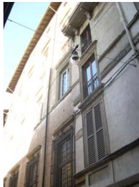
Cono di ripresa n. 9 Intonaco antico
