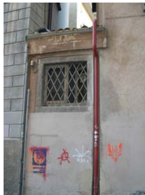
Cono di ripresa n. 9 Sovrastrutture tecnologiche da eliminare e riordinare percettivamente
