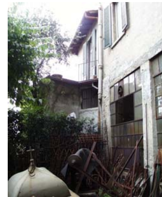
Cono di ripresa n. 35 Unità edilizia n.3 da rimuovere
