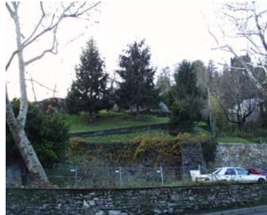
Cono di ripresa n. 5 Paramento murario da valorizzare
