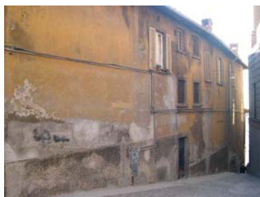
Cono di ripresa n. 13 Intonaco antico (unità edilizia n.13)
