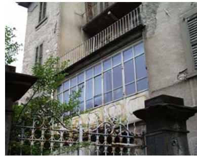
Cono di ripresa n. 6 Vetrata dell'unità edilizia n.4
