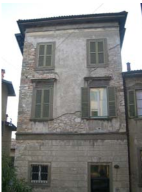
Cono di ripresa n. 10 Intonaco antico (unità edilizia n.2)
