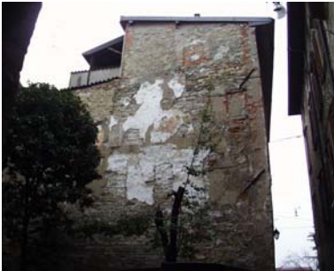
Cono di ripresa n. 1 Intonaci antichi sulla facciata dell'unità edilizia n.5
