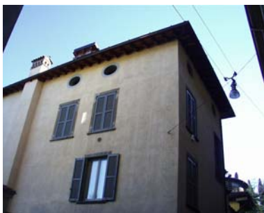
Cono di ripresa n. 2 Ordinamento architettonico dipinto conservato integralmente sulla facciata dell'unità edilizia n.7
