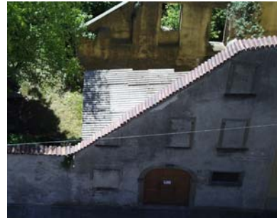
Cono di ripresa n. 8 Luogo dell'intervento di nuova edificazione
