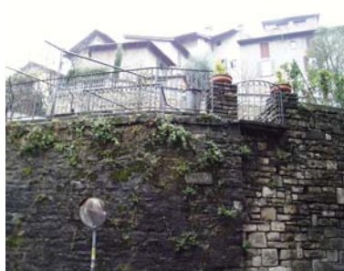
Cono di ripresa n. 12 Paramento murario da valorizzare in via San Lorenzo
