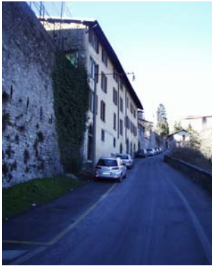
Cono di ripresa n. 3 Paramento murario da valorizzare in via Boccola
