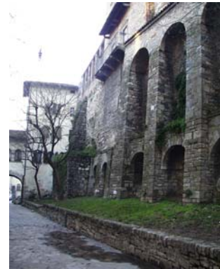
Cono di ripresa n. 4 Archi strutturali
