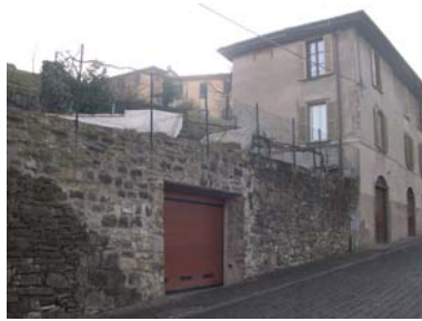
Cono di ripresa n. 14 Paramento murario da valorizzare in via Porta Dipinta
