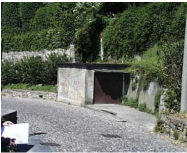
Cono di ripresa n. 11 Paramento murario attualmente intonacato adiacente all'unità edilizia n.2 da riconfigurare
