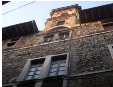
Cono di ripresa n. 10 Particolare della facciata dell'unità edilizia n.5
