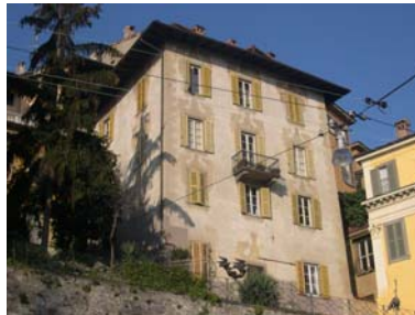
Cono di ripresa n. 11 Ordinamento architettonico dipinto sulla facciata dell'unità edilizia n.3
