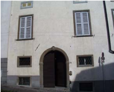
Cono di ripresa n. 4 Portale con stemma (unità edilizia n.4)
