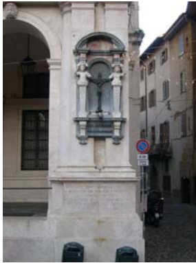
Cono di ripresa n. 9 Edicola sacra e iscrizione sulla facciata del Palazzo Nuovo (unità edilizia n.5)
