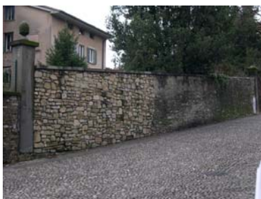
Cono di ripresa n. 10 Paramento murario da valorizzare in via Sudorno
