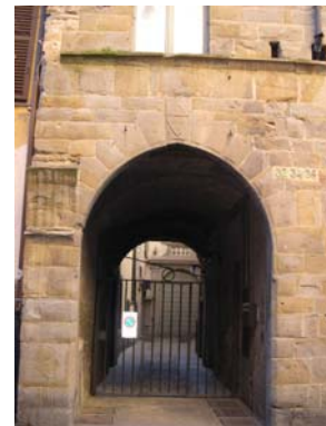
Cono di ripresa n. 9 Arco di ingresso al cortile interno
