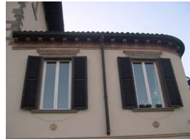
Cono di ripresa n. 10 Decorazione sottogronda sulla facciata dell'unità edilizia n.10
