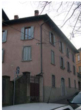
Cono di ripresa n. 14 Intervento recente sulla facciata dell'unità edilizia n.4
