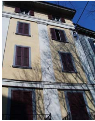
Cono di ripresa n. 10 Particolare delle lesene dell'unità edilizia n.2
