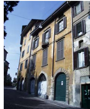
Cono di ripresa n. 1 Portali dell'unità edilizia n.2
