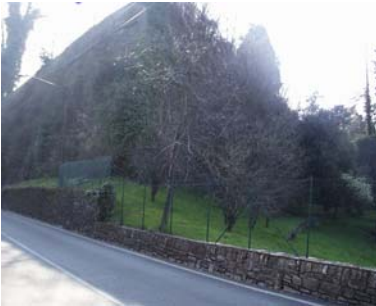
Cono di ripresa n. 1 Veduta delle Mura Venete del baluardo Pallavicino
