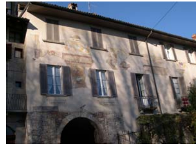
Cono di ripresa n. 5 Ordinamento architettonico dipinto sulla facciata della Porta del Pantano (unità edilizia n.3)
