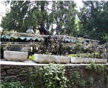
Cono di ripresa n. 6 Veranda da rimuovere (unità edilizia n.7)
