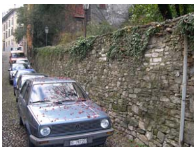
Cono di ripresa n. 14 Paramento murario da valorizzare in via San Lorenzo
