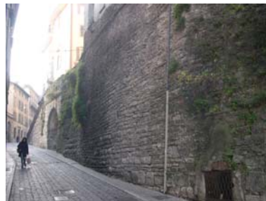
Cono di ripresa n. 9 Paramento murario da valorizzare in via Porta Dipinta
