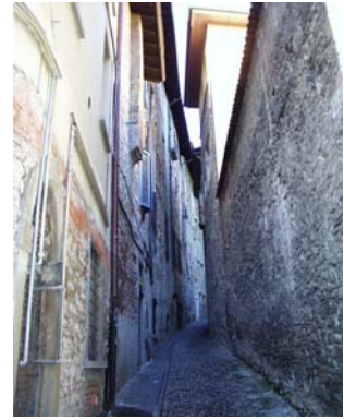
Cono di ripresa n. 1 Intonaco antico
