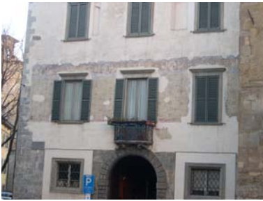
Cono di ripresa n. 8 Ordinamento architettonico dipinto conservato parzialmente sulla facciata dell'unità edilizia n.6
