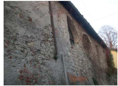
Cono di ripresa n. 7 Intonaco antico sull'unità edilizia n.2
