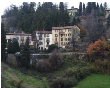
Cono di ripresa n. 1 Archi strutturali
