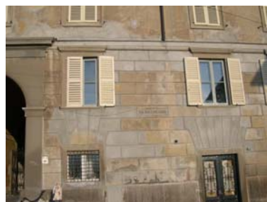
Cono di ripresa n. 24 Intonaco antico (unità edilizia n.13)
