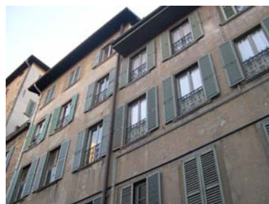
Cono di ripresa n. 12 Intonaco antico (unità edilizia n.2)
