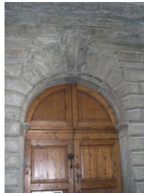
Cono di ripresa n. 12 Portale con stemma (unità edilizia n.4)
