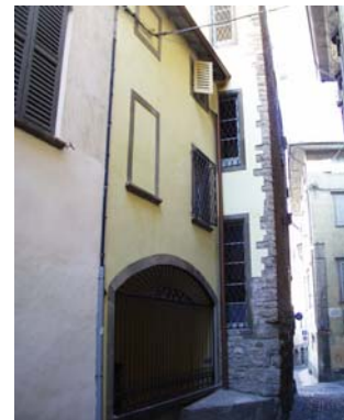
Cono di ripresa n. 4 Intervento recente sulla facciata dell'unità edilizia n.3
