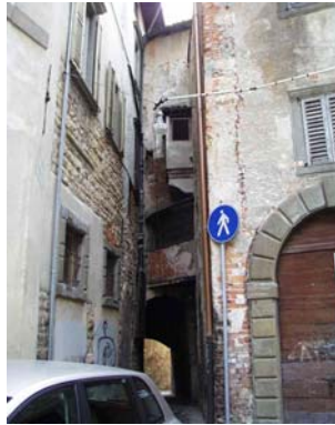
Cono di ripresa n. 4 Passaggio sotto costruzione di via Rosate
