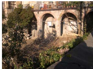
Cono di ripresa n. 12 Archi strutturali
