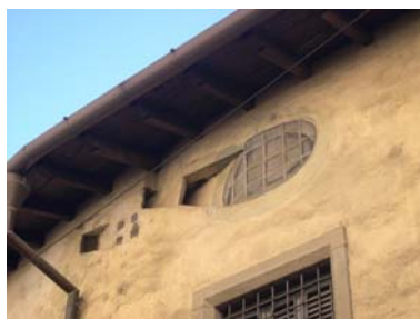
Cono di ripresa n. 11 Finestra trompe l'oeil e intonaco antico (unità edilizia n.1)
