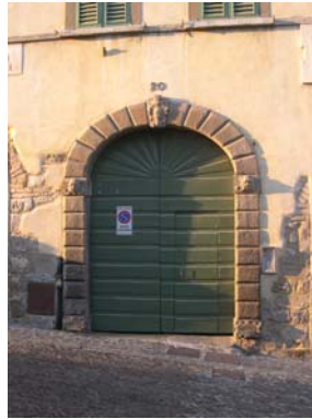
Cono di ripresa n. 11 Portale con stemma (unità edilizia n.1)
