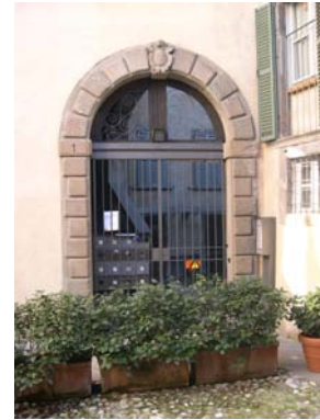
Cono di ripresa n. 6 Portale con stemma (unità edilizia n.8)
