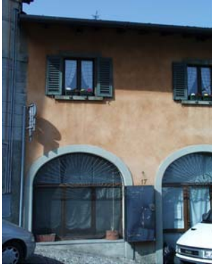
Cono di ripresa n. 3 Elemento tecnologico sulla facciata dell'unità edilizia n.2
