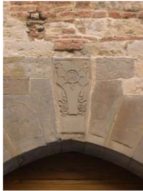
Cono di ripresa n. 9 Portale con stemma (unità edilizia n.2)
