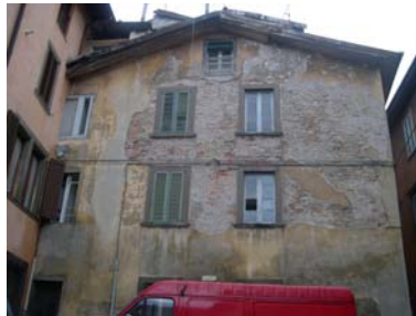
Cono di ripresa n. 11 Intonaco antico sulla facciata dell'unità edilizia n.6
