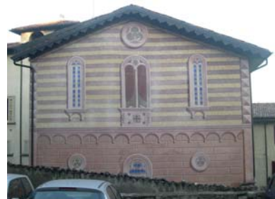
Cono di ripresa n. 13 Facciata trompe l'oeil dell'unità edilizia n.8
