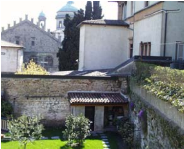
Cono di ripresa n. 4 Deposito attrezzi da rimuovere (unità edilizia n.1)
