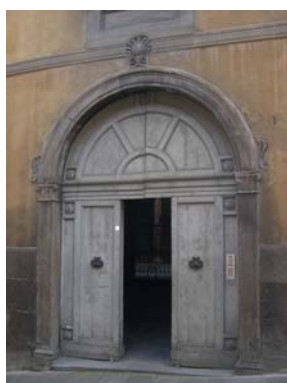
Cono di ripresa n. 21 Portale con stemma (unità edilizia n.5)
