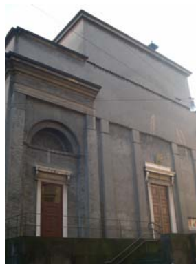
Cono di ripresa n. 11 Facciata della chiesa di Sant'Andrea
