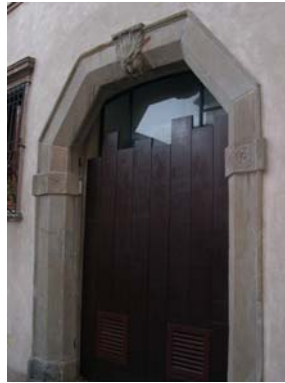
Cono di ripresa n. 9 Particolare della facciata dell'unità edilizia n.10
