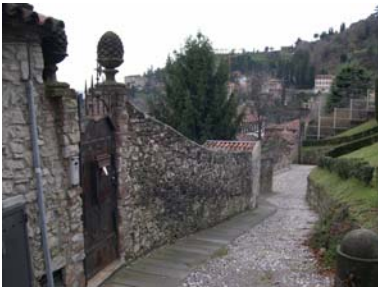
Cono di ripresa n. 7 Paramento murario da valorizzare in via Contradello
