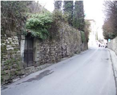
Cono di ripresa n. 3 Paramento murario da valorizzare in via San Lorenzo
