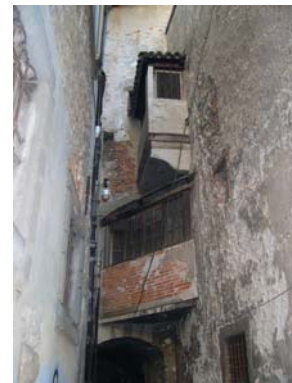
Cono di ripresa n. 4 Particolare del passaggio sotto costruzione di via Rosate
