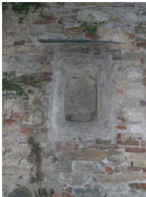
Cono di ripresa n. 12 Nicchia (unità edilizia n.5)
