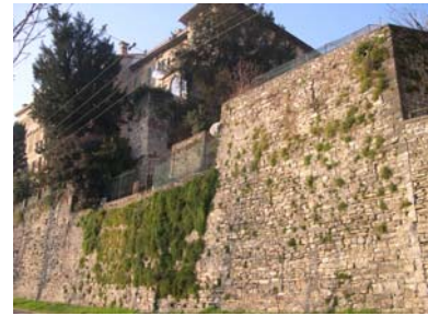
Cono di ripresa n. 13 Paramento murario da valorizzare sul viale delle Mura
