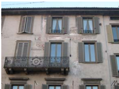
Cono di ripresa n. 13 Ordinamento architettonico dipinto sull'unità edilizia n. 13
