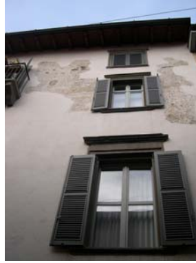
Cono di ripresa n. 5 Intonaco antico sulla facciata dell'unità edilizia n.10
