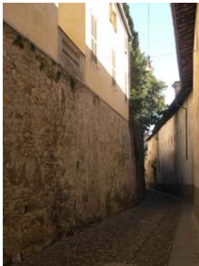
Cono di ripresa n. 11 Intonaco antico
