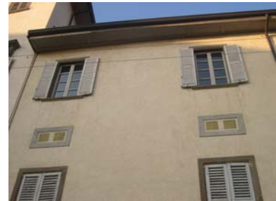
Cono di ripresa n. 5 Finestre trompe l'oeil sulla facciata dell'unità edilizia n.4
