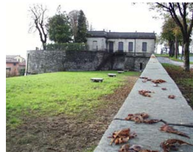
Cono di ripresa n. 10 Baluardo di San Michele e prato di copertura dell'edificio dell'acquedotto
