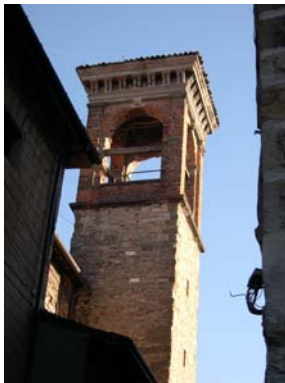
Cono di ripresa n. 9 Campanile
