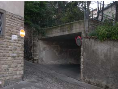
Cono di ripresa n. 11 Ingresso ad autorimessa (unità ipogea n.1)
