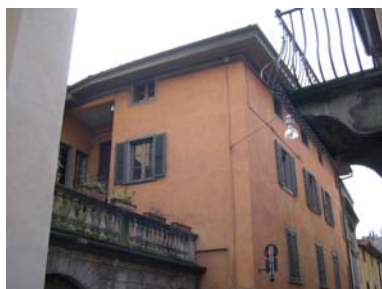
Cono di ripresa n. 9 Sottogronda sulla facciata dell'unità edilizia n.1
