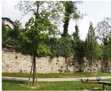
Cono di ripresa n. 11 Paramento murario da valorizzare
