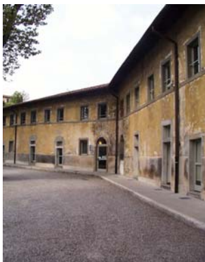
Cono di ripresa n. 48 Intonaci antichi
