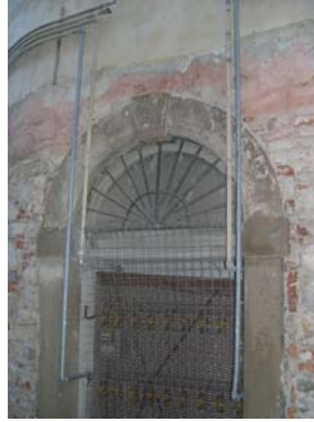
Cono di ripresa n. 4 Portale e elementi tecnologici (unità edilizia n.1)
