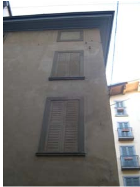
Cono di ripresa n. 7 Finestre trompe l'oeil sulla facciata dell'unità edilizia n.8
