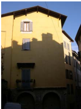
Cono di ripresa n. 11 Intervento recente sulla facciata dell'unità edilizia n.3
