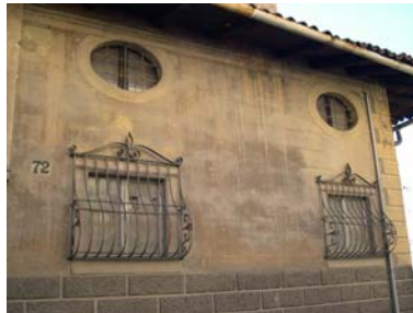
Cono di ripresa n. 13 Particolare dell'ordinamento architettonico dipinto sulla facciata dell'unità edilizia n. 5
