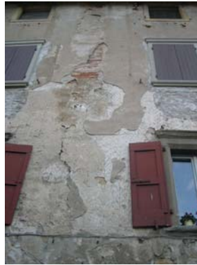
Cono di ripresa n. 5 Ordinamento architettonico dipinto conservato parzialmente sulla facciata dell'unità edilizia n.1
