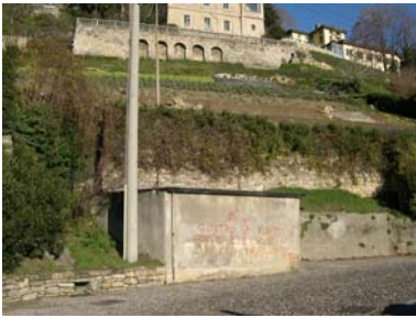
Cono di ripresa n. 7 Archi strutturali, terrazzamenti e orti
