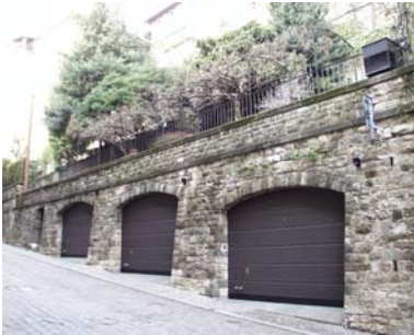
Cono di ripresa n. 6 Ingressi alle autorimesse (unità ipogea n.1) in via Porta Dipinta
