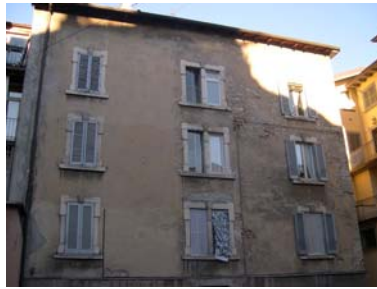
Cono di ripresa n. 7 Intonaco antico sulle facciate dell'unità edilizia n.4
