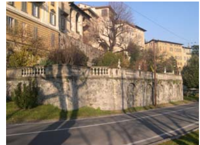
Cono di ripresa n. 12 Paramento murario da valorizzare, archi strutturali e balaustre di coronamento con "putti" scultorei
