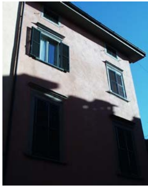
Cono di ripresa n. 4 Intervento recente sulla facciata dell'unità edilizia n.7
