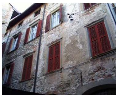
Cono di ripresa n. 20 Intonaco antico sulla facciata dell'unità edilizia n.8
