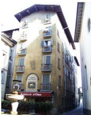
Cono di ripresa n. 7 Meridiana sulla facciata dell'unità edilizia n.6
