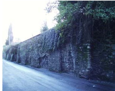
Cono di ripresa n. 6 Archi strutturali
