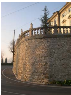
Cono di ripresa n. 10 Paramento murario da valorizzare sul viale delle Mura
