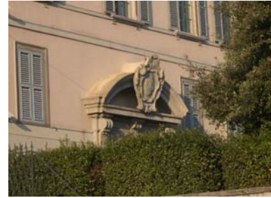
Cono di ripresa n. 7 Portale con stemma (unità edilizia n.1)
