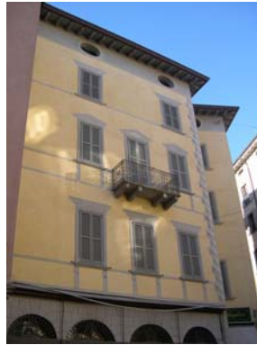
Cono di ripresa n. 12 Ordinamento architettonico dipinto sulla facciata dell'unità edilizia n.4
