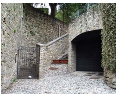
Cono di ripresa n. 11 Percorso pedonale da recuperare
