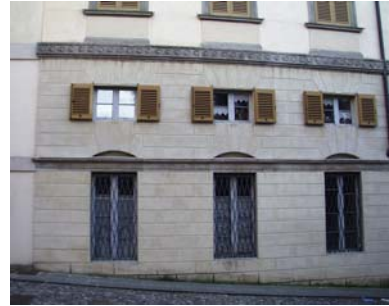
Cono di ripresa n. 3 Particolare della facciata dell'unità edilizia n. 1
