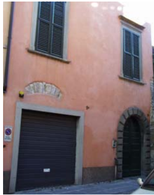
Cono di ripresa n. 5 Intervento recente sulla facciata dell'unità edilizia n.7
