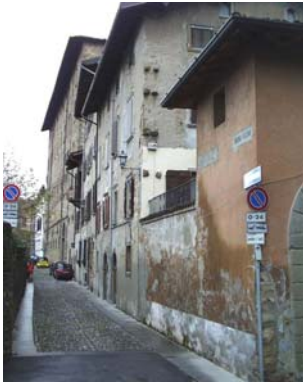
Cono di ripresa n. 1 Intonaci antichi sulle facciate delle unità edilizie n.1 e n.2
