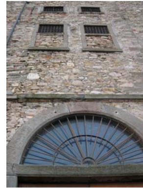
Cono di ripresa n. 6 Particolare della facciata dell'unità edilizia n.5
