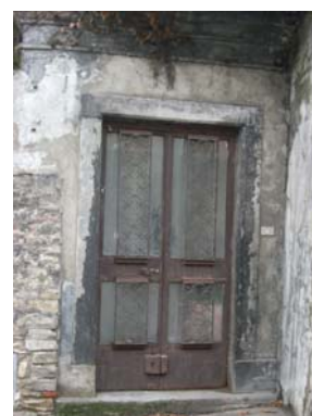
Cono di ripresa n. 7 Porta di ingresso all'unità edilizia n.2 dalla via Sudorno
