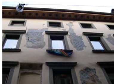
Cono di ripresa n. 12 Ordinamento architettonico dipinto e sottogronda sull'unità edilizia n.3
