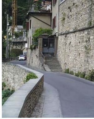
Cono di ripresa n. 8 Scaletta e ingresso da salvaguardare
