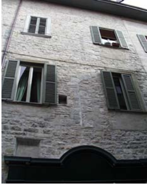
Cono di ripresa n. 5 Particolare della facciata dell'unità edilizia n.1
