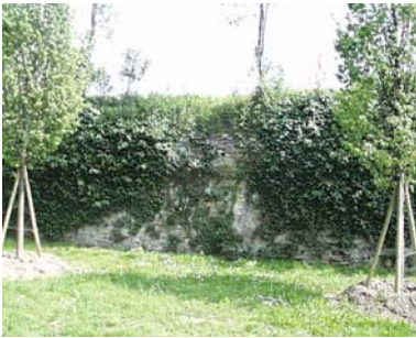
Cono di ripresa n. 10 Paramento murario da valorizzare
