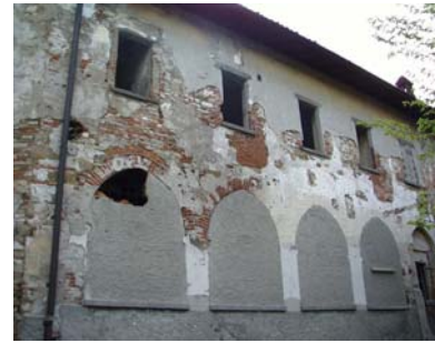
Cono di ripresa n. 49 Intonaci antichi
