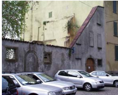
Cono di ripresa n. 7 Luogo dell'intervento di nuova edificazione
