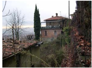
Cono di ripresa n. 11 Tettoia da rimuovere (unità edilizia n.5)
