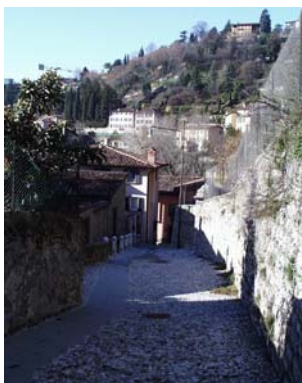
Cono di ripresa n. 4 Paramento murario da valorizzare in via Contradello
