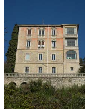
Cono di ripresa n. 3 Intonaco antico sull'unità edilizia n.1
