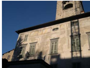
Cono di ripresa n. 7 Decorazioni pittoriche sulla facciata dell'unità edilizia n. 1
