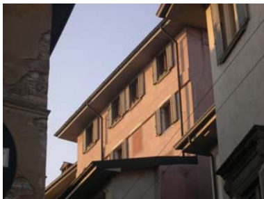
Cono di ripresa n. 7 Finestre trompe l'oeil sull'unità edilizia n.2
