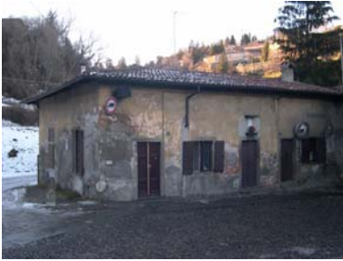
Cono di ripresa n. 8 Intonaco antico sull'unità edilizia n.7
