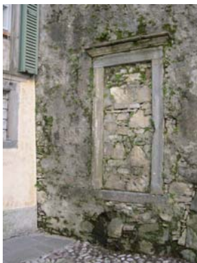
Cono di ripresa n. 7 Finestra integrata nel muro in pietra
