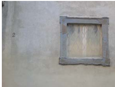
Cono di ripresa n. 5 Finestra trompe l'oeil sulla facciata di Palazzo Terzi (unità edilizia n.2)
