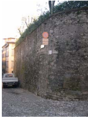
Cono di ripresa n. 5 Paramento murario da valorizzare in via Salvecchio
