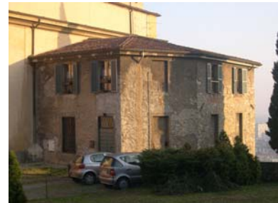
Cono di ripresa n. 12 Intonaco antico (unità edilizia n.1)
