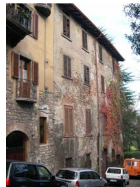
Cono di ripresa n. 13 Ordinamento architettonico dipinto parzialmente conservato e intonaco antico sull'unità edilizia n.1
