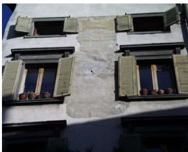
Cono di ripresa n. 20 Ordinamento architettonico dipinto conservato parzialmente sulla facciata dell'unità edilizia n.7
