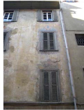
Cono di ripresa n. 7 Ordinamento architettonico dipinto sulla facciata dell'unità edilizia n.4
