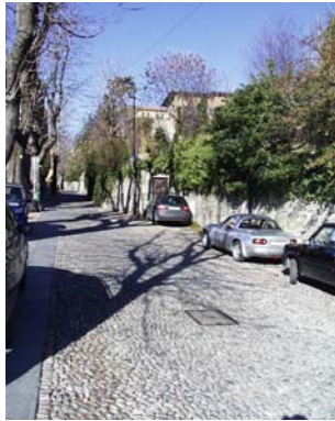
Cono di ripresa n. 4 Paramento murario da valorizzare in via San Vigilio
