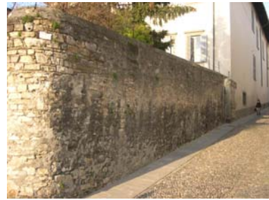
Cono di ripresa n. 5 Paramento murario da valorizzare sul vicolo Mura di Santa Grata
