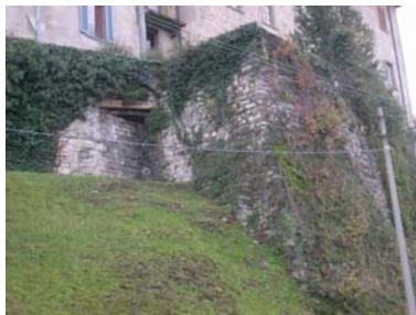
Cono di ripresa n. 12 Paramento murario da valorizzare
