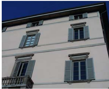
Cono di ripresa n. 3 Particolare della facciata dell'unità edilizia n.1
