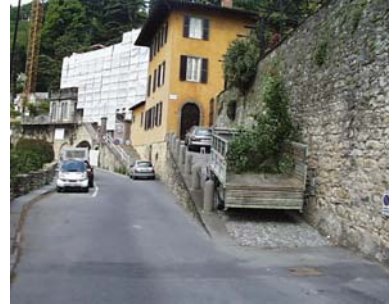
Cono di ripresa n. 10 Scaletta e ingresso da salvaguardare
