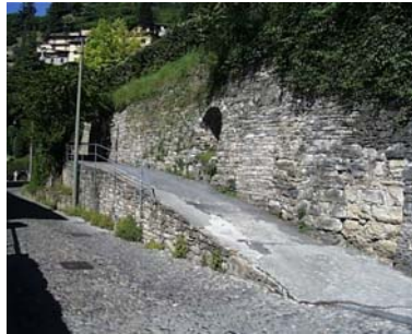
Cono di ripresa n. 8 Scaletta e ingresso da salvaguardare
