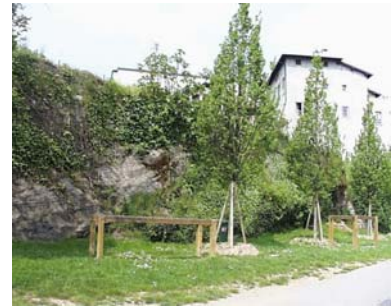
Cono di ripresa n. 14 Paramento murario da valorizzare
