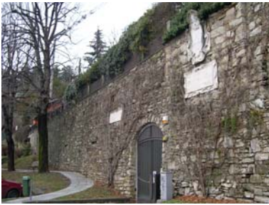
Cono di ripresa n. 7 Paramento murario da valorizzare
