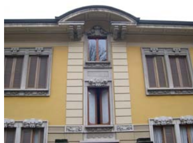
Cono di ripresa n. 9 Particolare della facciata dell'unità edilizia n.2
