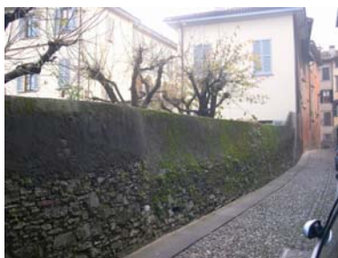
Cono di ripresa n. 11 Paramento murario da valorizzare in via Vagine
