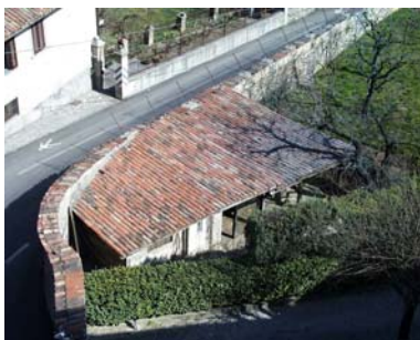
Cono di ripresa n. 4 Baracca in muratura da rimuovere (unità edilizia n.2)
