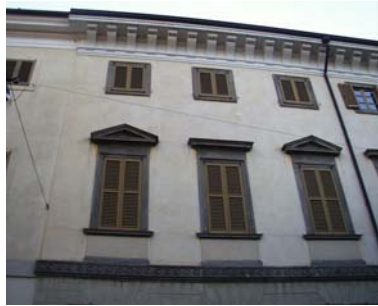
Cono di ripresa n. 2 Intervento recente sulla facciata dell'unità edilizia n. 1
