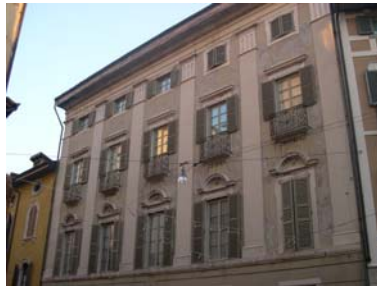
Cono di ripresa n. 19 Intonaco antico (unità edilizia n.5)
