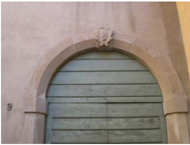
Cono di ripresa n. 9 Portale con stemma (unità edilizia n.1)
