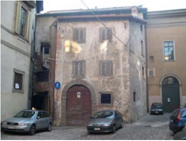
Cono di ripresa n. 3 Intonaco antico sulla facciata dell'unità edilizia n.1
