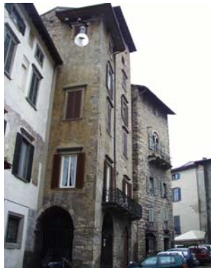
Cono di ripresa n. 28 Intonaci antichi (unità edilizia n.2)
