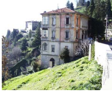
Cono di ripresa n. 2 Intonaco antico sull'unità edilizia n.1
