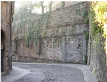
Cono di ripresa n. 8 Paramento murario da valorizzare in via San Giacomo conservando le partiture architettoniche e gli elementi compositivi dell'elemento murario. Mascheroni, nicchie e bucatore.
