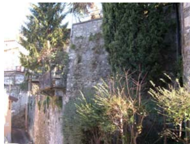
Cono di ripresa n. 16 Paramento murario da valorizzare in via degli Orti
