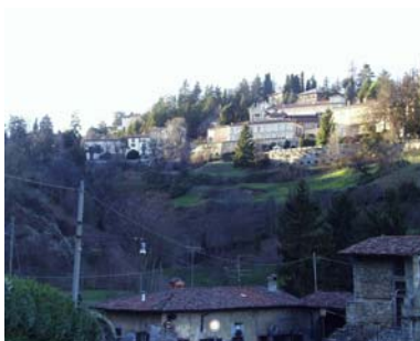
Cono di ripresa n. 1 Archi strutturali e terrazzamenti
