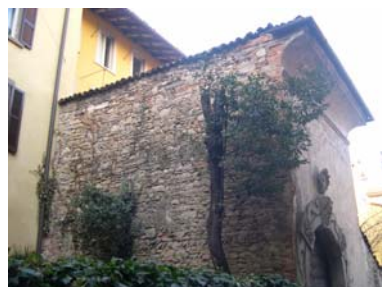
Cono di ripresa n. 10 Paramento murario da valorizzare sull'unità edilizia n.3
