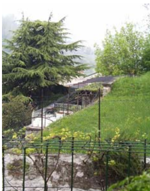
Cono di ripresa n. 10 Baracca (unità edilizia n.2) da rimuovere
