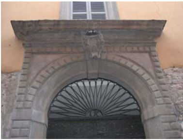
Cono di ripresa n. 11 Portale con stemma (unità edilizia n.2)
