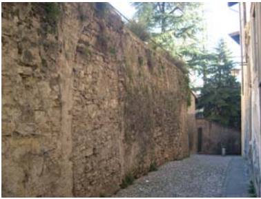
Cono di ripresa n. 10 Intonaco antico e paramento murario da valorizzare (unità edilizia n.8)
