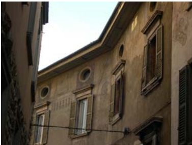
Cono di ripresa n. 9 Decorazione pittorica a palinsesto sull'unità edilizia n.1
