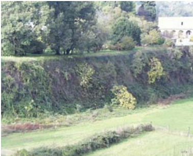
Cono di ripresa n. 4 Paramento murario sul Baluardo della Fara
