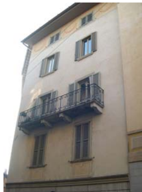
Cono di ripresa n. 15 Decorazione pittorica sottogronda sulla facciata delle unità edilizie n.3 e n.7
