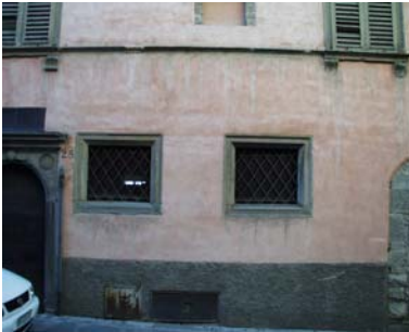
Cono di ripresa n. 2 Particolare della facciata dell'unità edilizia n.7
