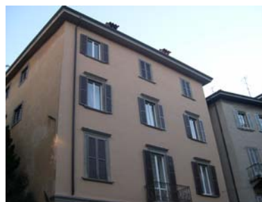
Cono di ripresa n. 10 Intervento recente sulla facciata dell'unità edilizia n.3
