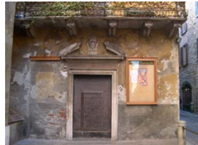
Cono di ripresa n. 19 Stemma e intonaci antichi sulle facciate delle unità edilizie n.4 e n.5
