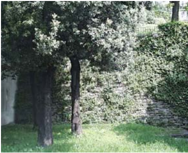
Cono di ripresa n. 26 Paramento murario da valorizzare sul viale delle Mura
