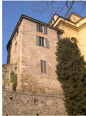
Cono di ripresa n. 5 Intonaco antico (unità edilizia n.1)
