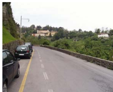
Cono di ripresa n. 20 Paramento murario da valorizzare in via Boccola
