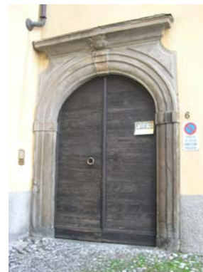
Cono di ripresa n. 19 Portale con stemma (unità edilizia n.7)
