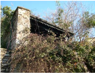
Cono di ripresa n. 9 Gazebo in ferro da rimuovere (unità edilizia n.6)
