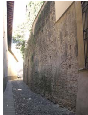
Cono di ripresa n. 10 Intonaco antico
