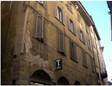
Cono di ripresa n. 4 Ordinamento architettonico dipinto sull'unità edilizia n.4
