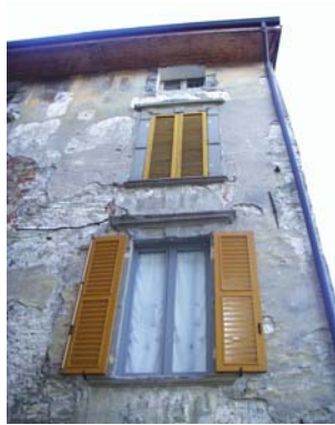
Cono di ripresa n. 6 Intonaci antichi sull'unità edilizia n.3
