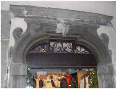
Cono di ripresa n. 10 Portale con stemma (unità edilizia n.2)
