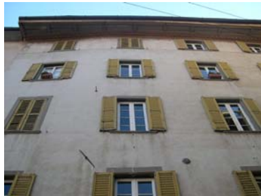
Cono di ripresa n. 10 Ordinamento pittorico sottogronda sulla facciata dell'unità edilizia n.1
