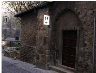
Cono di ripresa n. 13 Unità edilizia da rimuovere
