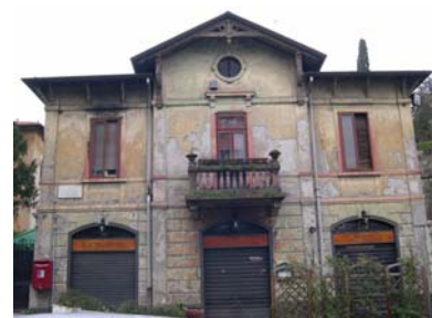
Cono di ripresa n. 2 Intonaco antico sull'unità edilizia n.2
