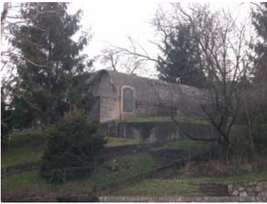
Cono di ripresa n. 4 Serbatoio d'acqua (unità edilizia n.1)
