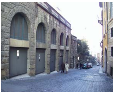
Cono di ripresa n. 6 Ingressi ad autorimesse in via Porta Dipinta (unità edilizia n.1)
