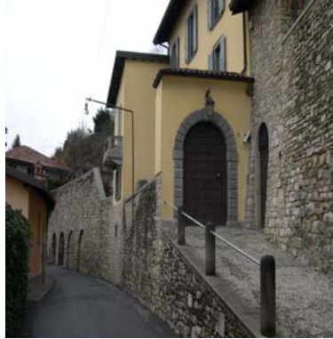
Cono di ripresa n. 5 Scaletta e ingresso da salvaguardare. Archi strutturali
