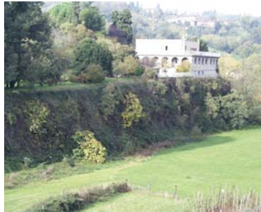
Cono di ripresa n. 5 Paramento murario sul Baluardo della Fara
