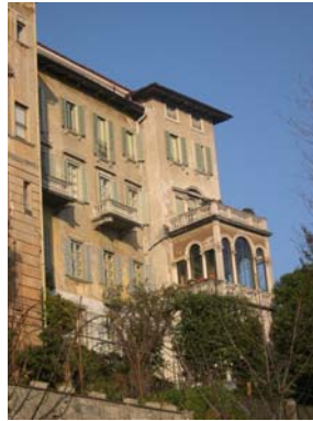
Cono di ripresa n. 10 Intonaci antichi sulle unità edilizie n.2 e n.5
