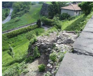
Cono di ripresa n. 22 Paramento murario da valorizzare in via Boccola
