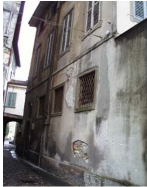
Cono di ripresa n. 14 Intonaci antichi sulla facciata dell'unità edilizia n.5
