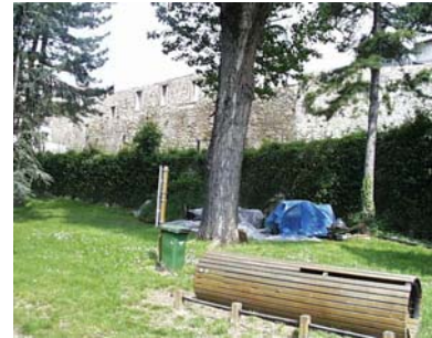
Cono di ripresa n. 9 Paramento murario da valorizzare
