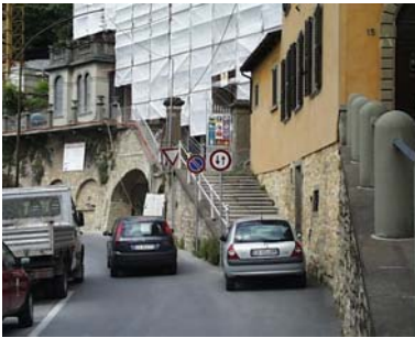
Cono di ripresa n. 12 Scaletta e ingresso da salvaguardare. Archi strutturali
