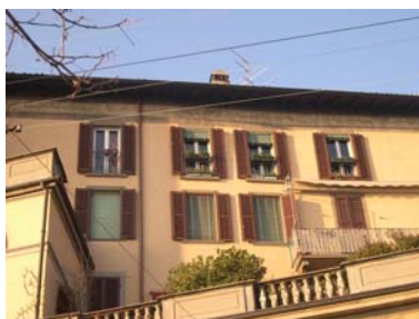
Cono di ripresa n. 11 Decorazione pittorica sottogronda sull'unità edilizia n.1
