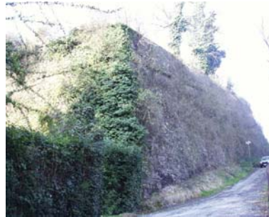
Cono di ripresa n. 2 Veduta delle Mura Venete del baluardo Pallavicino
