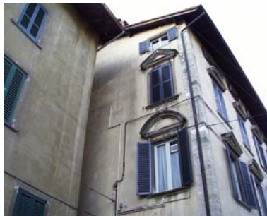
Cono di ripresa n. 14 Particolare dei frontoni delle finestre dell'unità edilizia n.3
