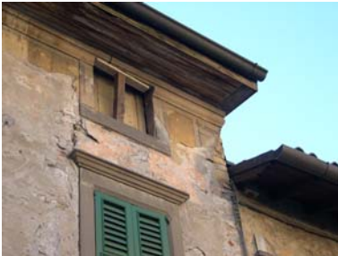
Cono di ripresa n. 19 Particolare del sottogronda dell'unità edilizia n.5
