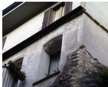
Cono di ripresa n. 18 Ordinamento architettonico dipinto sulla facciata dell'unità edilizia n.2
