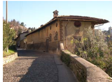
Cono di ripresa n. 14 Ordinamento architettonico dipinto sulla facciata dell'unità edilizia n. 5
