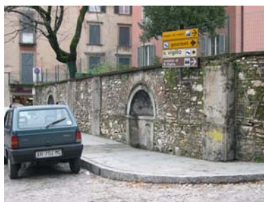
Cono di ripresa n. 11 Paramento murario da valorizzare in largo Sant'Alessandro
