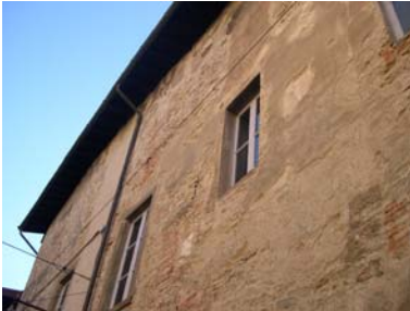
Cono di ripresa n. 5 Intonaco antico
