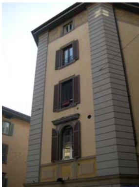
Cono di ripresa n. 14 Decorazione pittorica sottogronda sulla facciata dell'unità edilizia n.3
