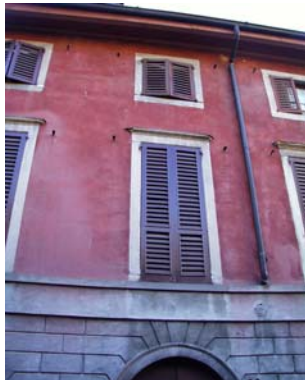
Cono di ripresa n. 5 Particolare della facciata dell'unità edilizia n.8
