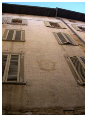
Cono di ripresa n. 15 Ordinamento architettonico dipinto e stemma sulla facciata delle unità edilizie n.2 e n.7
