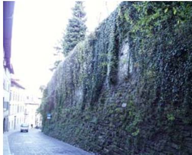
Cono di ripresa n. 9 Paramento murario da valorizzare in via San Lorenzo
