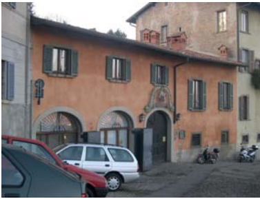
Cono di ripresa n. 11 Insegna sulla facciata dell'unità edilizia n.2
