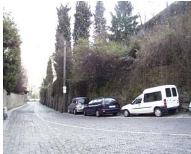
Cono di ripresa n. 5 Paramento murario da valorizzare in via San Lorenzo
