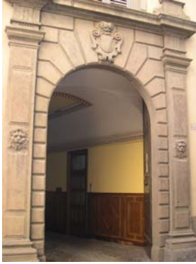
Cono di ripresa n. 1 Portale con stemma all'ingresso dell'unità edilizia n.3
