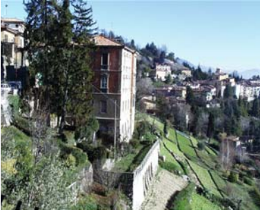
Cono di ripresa n. 1 Terrazzamenti e archi strutturali
