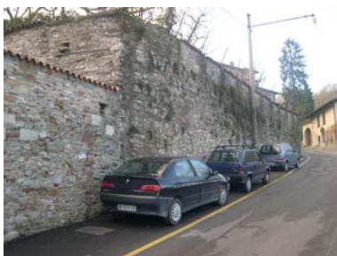
Cono di ripresa n. 9 Paramento murario da valorizzare in via Boccola
