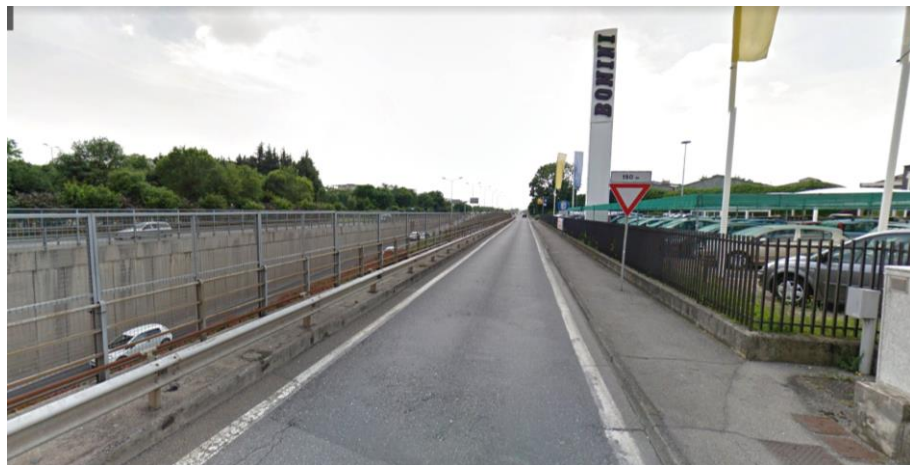
Foto 2 – S2: SS 671 (rampa in entrata verso carreggiata nord)
