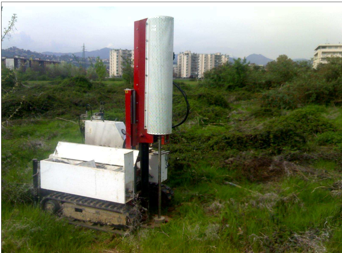
Fig. 22: Esecuzione prove penetrometriche
