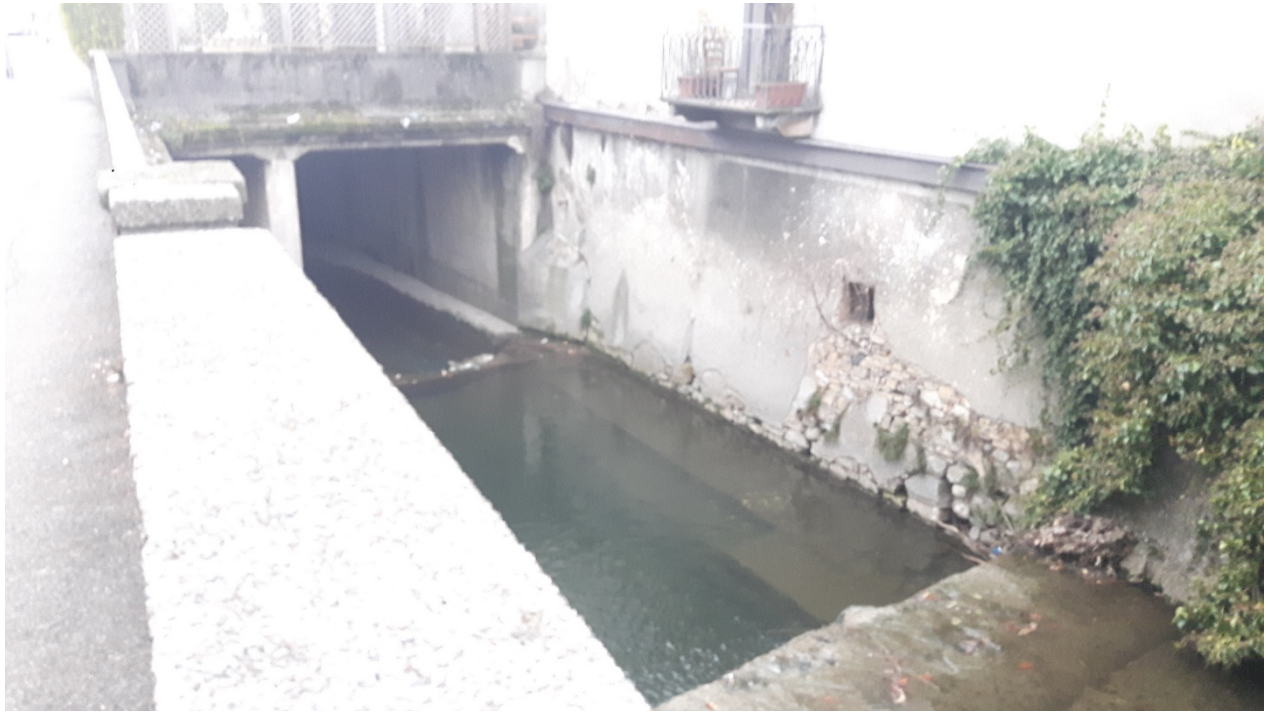
Figura 7.15: Tombinatura di Piazzale Oberdan e traversa posta circa 13m a monte.
