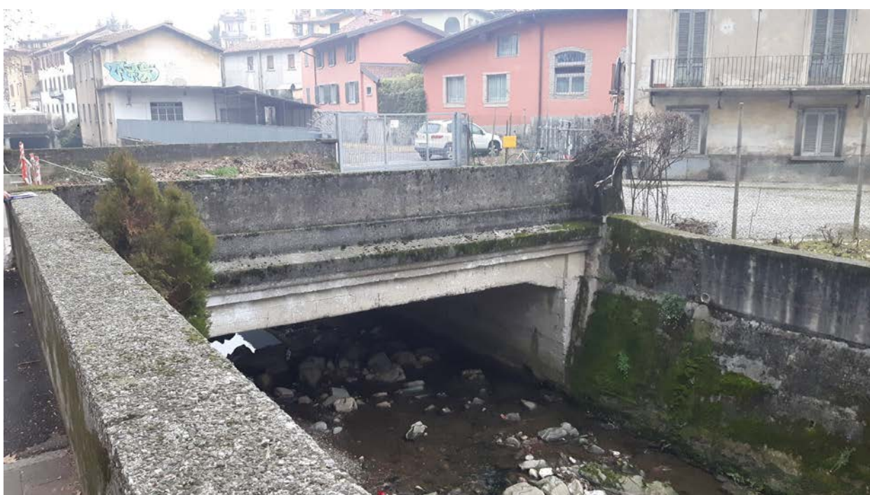
Figura 7.14: Ponte compreso tra le sezioni 05-M e 05-V.
