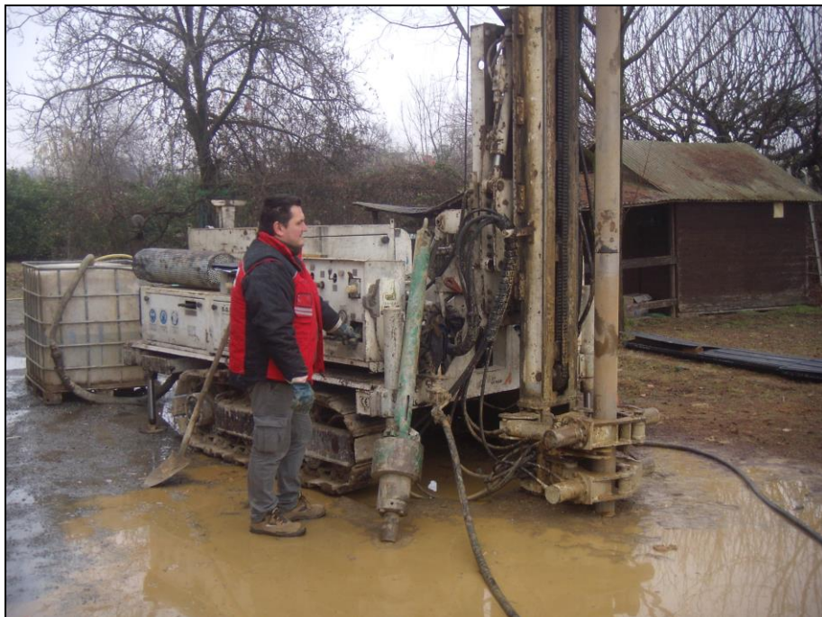
Fase di esecuzione del sondaggio meccanico
