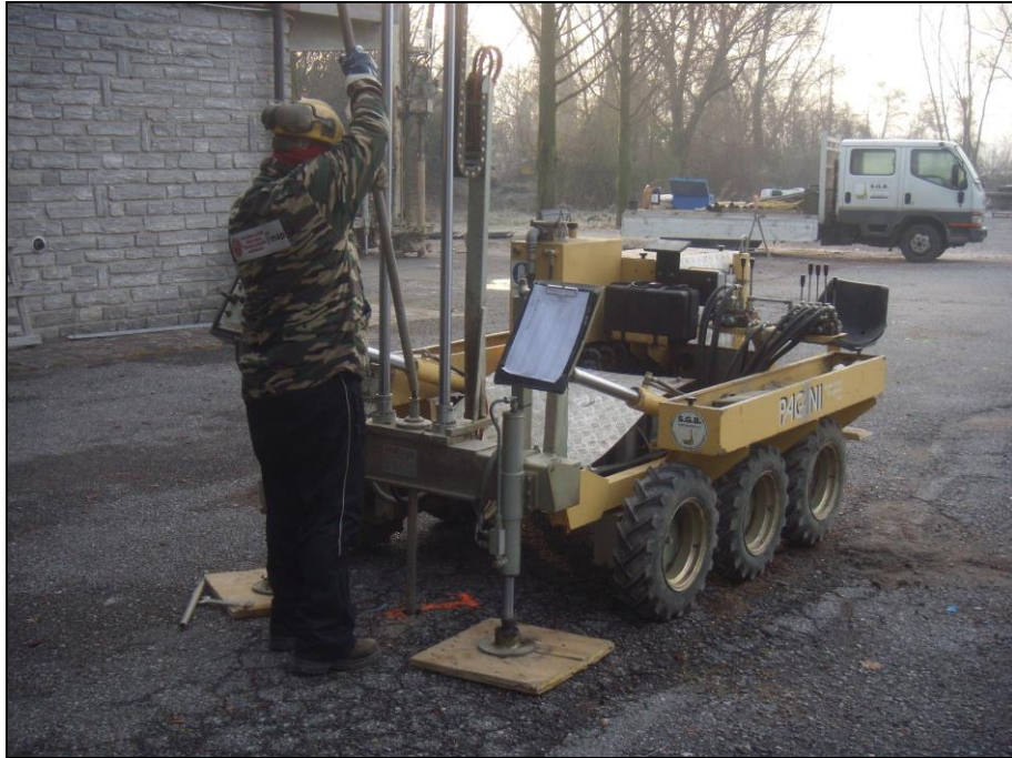
Fase di esecuzione delle prove penetrometriche
